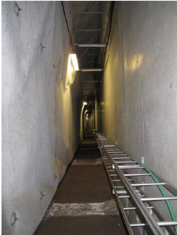
Figur 6: Bild på installationskorridoren, med dukmembran på vänster sida och kulvertvägg av betong till höger (RISE).
