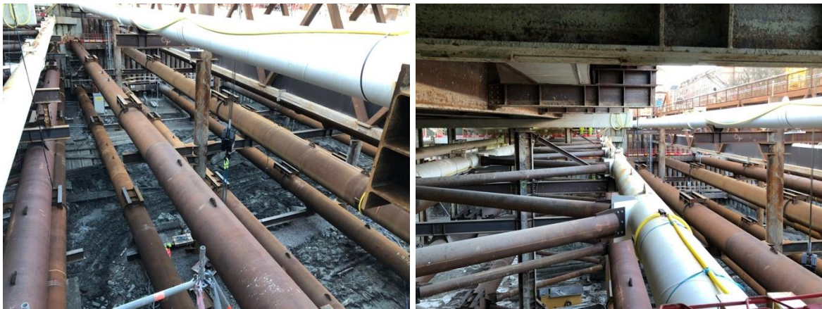
Figur 15 – Djupa schakter med vek stödväggskonstruktion kräver flera nivåer av stämp vilket skapar fysiska hinder
