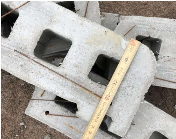
Figur 50 – Distans (ca. 120 mm) mellan armeringskorg och slitsvägg
