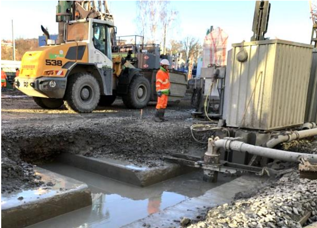
Figur 34 - Fotografiet visar exempel på hur stödvätskeanordningen installeras genom att anordningen hängs på styrväggarnas överkant
