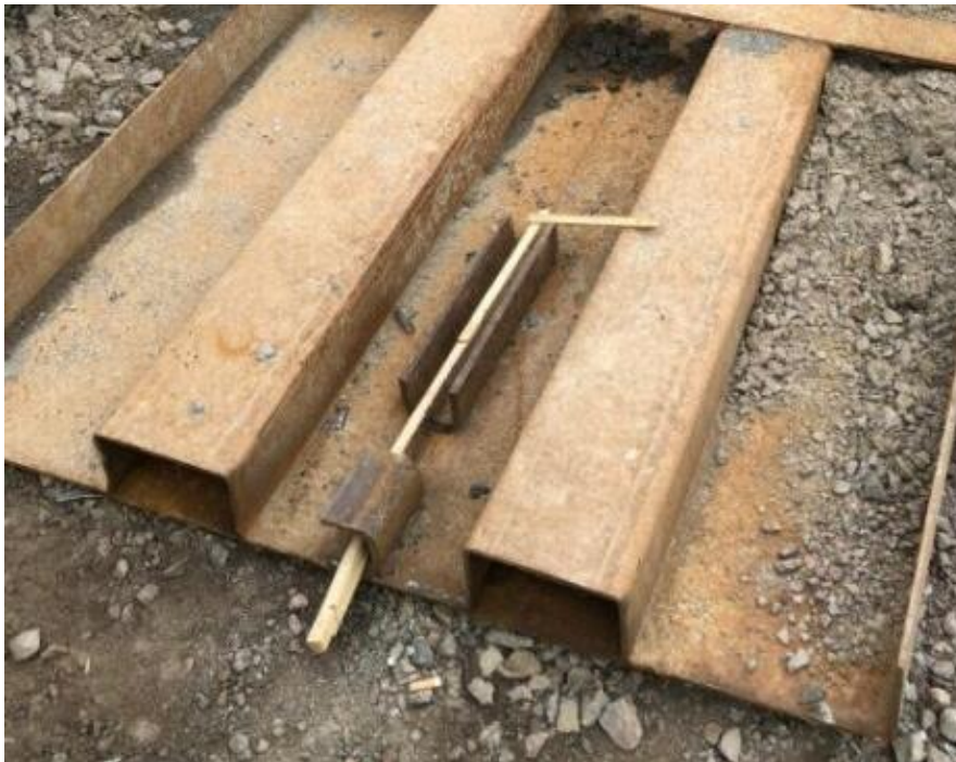
Figur 46 - Låsmekanism mellan temporärt och permanent stoppelement i stål. Tumstocken med vinkel agerar låsning
