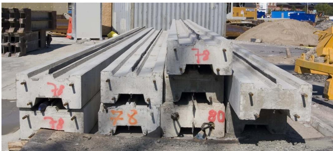
Figur 44 – Stoppelement av betong med fogband för vattentätet (Fotografi: Per Lindh 2006)
