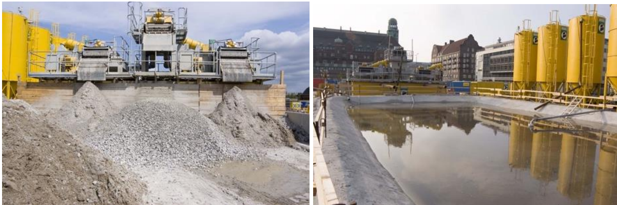
Figur 10 – Exempel på två delprocesser i reningsanläggningen som krävs för att rena stödvätskan. T.v. Högar av separerade fraktioner. T.h. Sedimenteringsbassäng (Fotografi: Per Lindh 2006)
