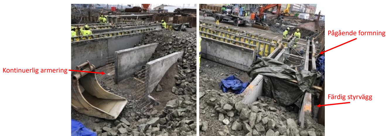
Figur 30 - Platsgjutna styrväggar. T.v. kontinuerlig horisontell armering. T.h. formning och färdiggjuten styrvägg
