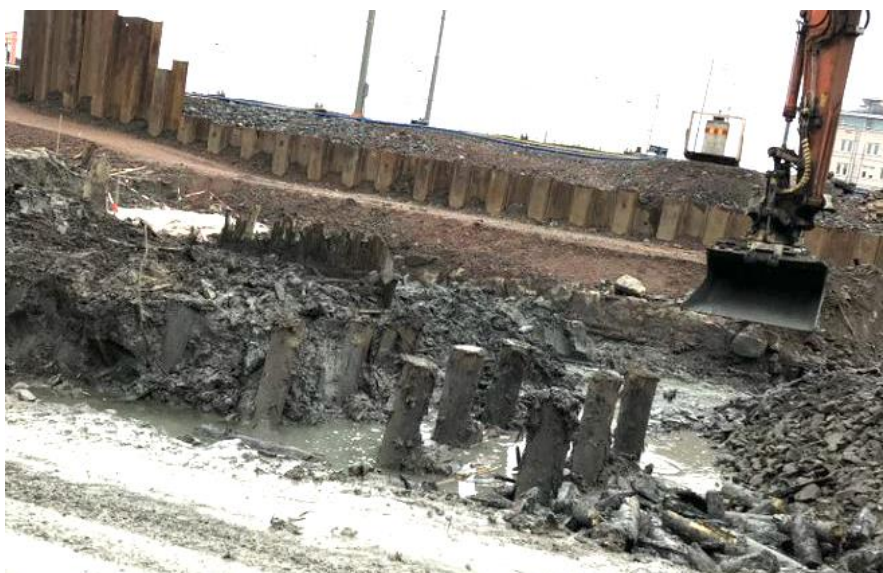
Figur 25 - Förberedande arbeten: borttagning av träpålar
