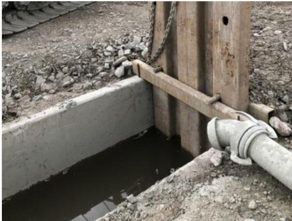
Figur 33 – Fotografiet visar exempel på hur stoppelementen (vertikala fogarna) mellan panelerna installeras. Installation sker genom att stoppelementen hängs på styrväggarnas överkant
