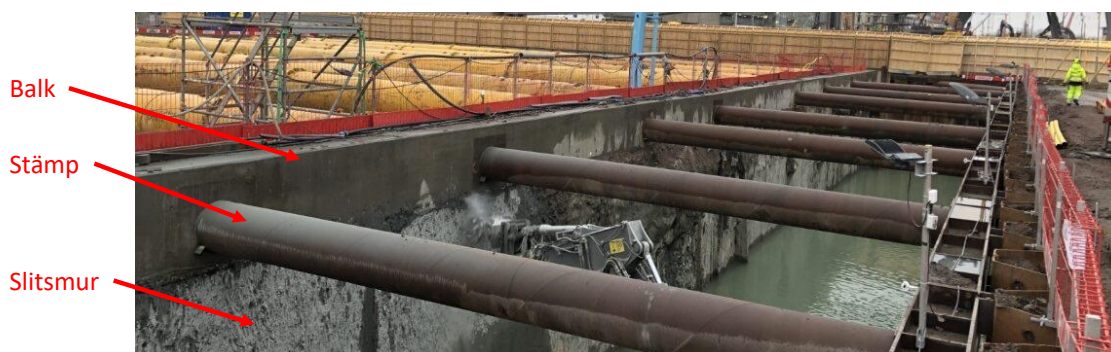
Figur 62 – Den kontinuerliga balken sett från ena sidan. Notera balkkonstruktionen inkl. stämp och slitsmur
