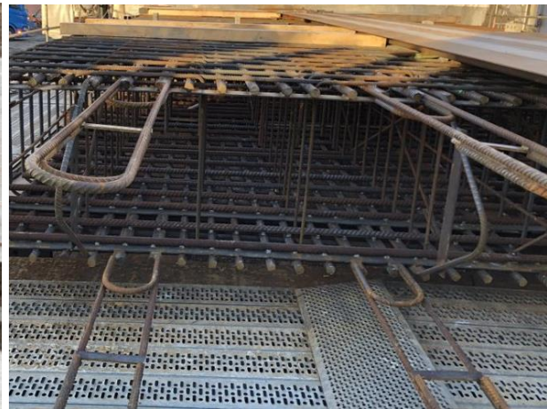
Figur 51 – Armeringskorgen hängs upp i styrväggarna genom de uppstickande U-formade armeringsjärnen
