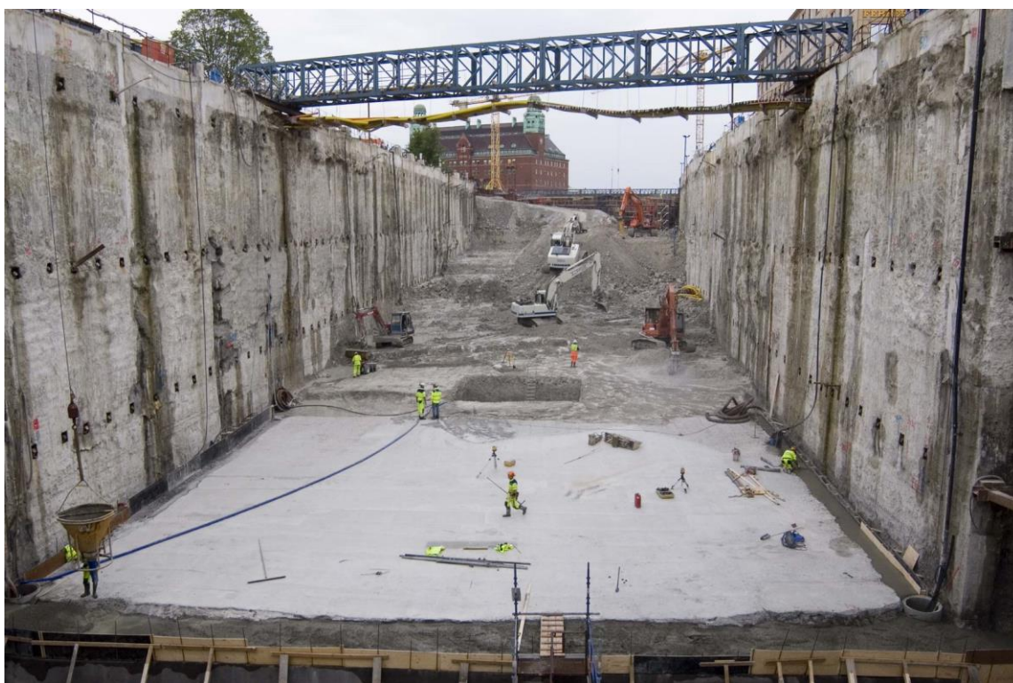
Figur 7 - Exempel på hur en slitsmur kan se ut (Fotografi: Per Lindh 2006)
