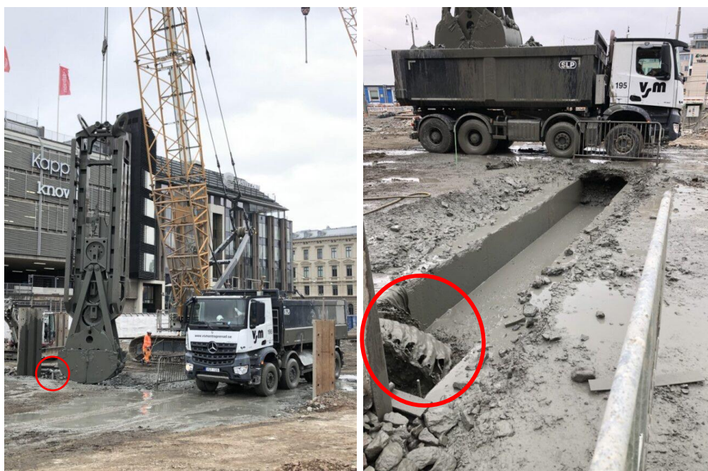
Figur 36 – Fotografier av samma slitsschakt från två vyer. Schakt och pumpning av stödvätska in i schaktet sker samtidigt. De två röda ringarna markerar stödvätskans inflöde i slitsen. Notera gripskopans storlek och utseende
