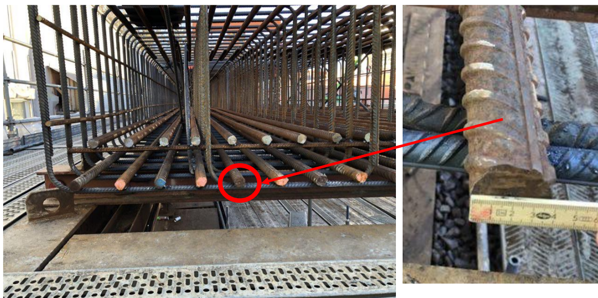
Figur 52 – T.v. Dubbla lager av longitudinell armering T.h. närbild på ett av de longitudinella armeringsjärnen. Cirka 40 mm
