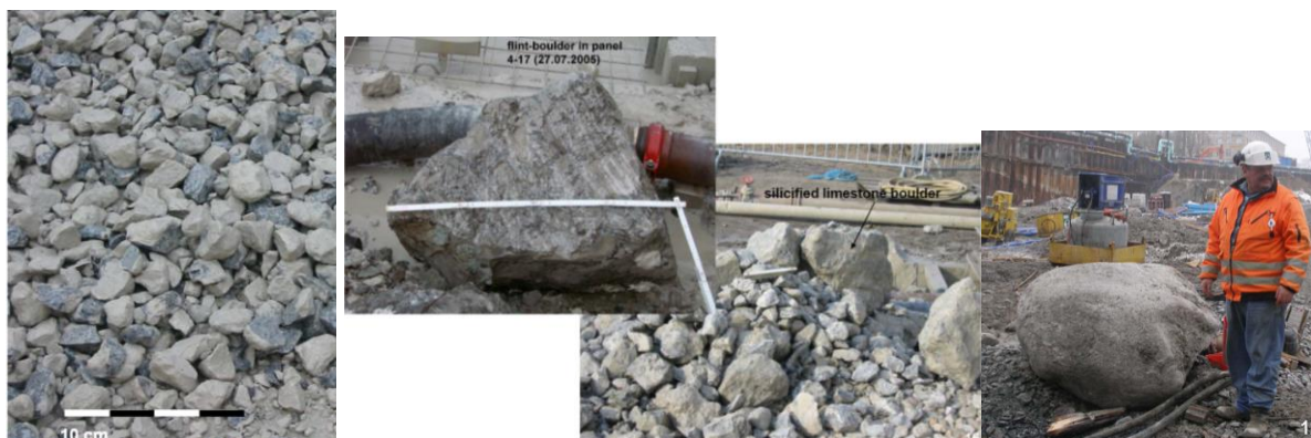
Figur 75 - Exempel på uppschaktat stenmaterial. Notera den stora storleken på stenmaterialet vilket försvårade uppschaktning med gripskopa (Scholz & Linder 2007)
