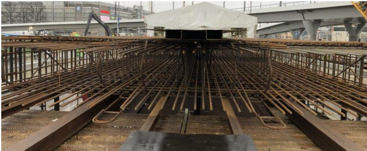
Figur 49 - Armeringskorg som förbereds på armeringsstationen. Notera dess stora storlek
