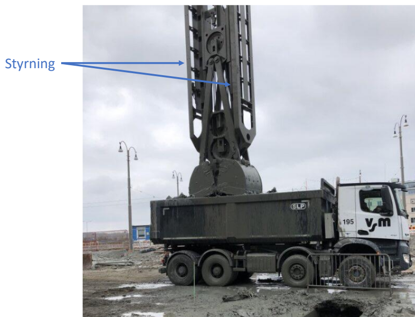
Figur 37 - Gripskopsaggregatets styrning är markerad. Styrningen (likt vertikala väggar) styr skopan rätt i slitsschaktet
