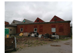
Bild 14. Väveriets västra fasad
