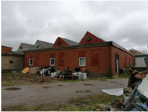
Bild 9. Väveriets västra fasad
