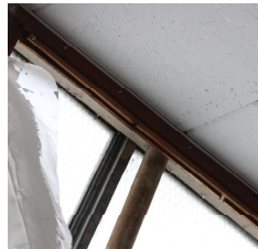
Fönsterkarmar i stål eller gjutjärn
