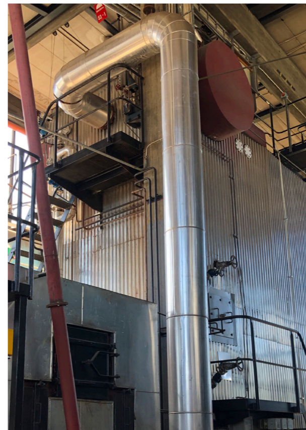
Plåt inne i och omkring byggnaden
