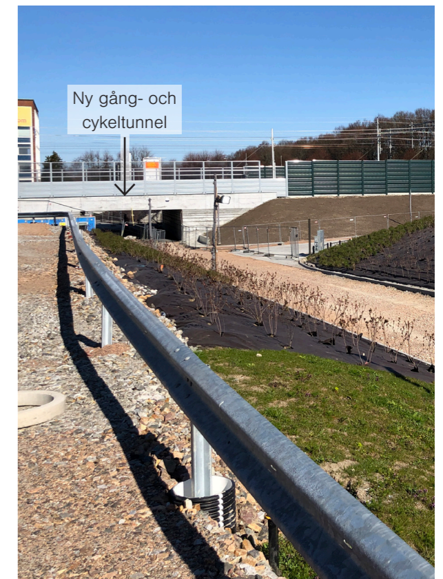
Den nya tunneln under tågspåret
