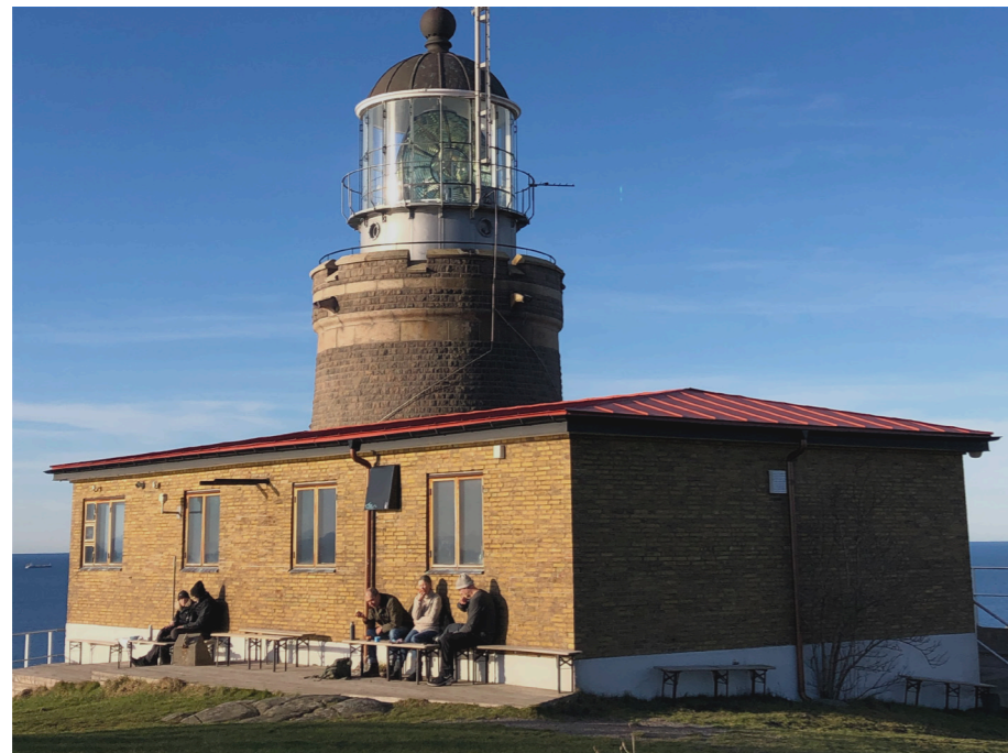
BILD 6 / Bänkar mot fyrbyggnadens solvägg, januari 2023.
