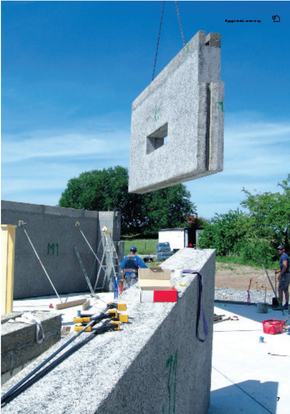
Ett Trällit helväggselement lyfts på plats (trällit.se 2023)
