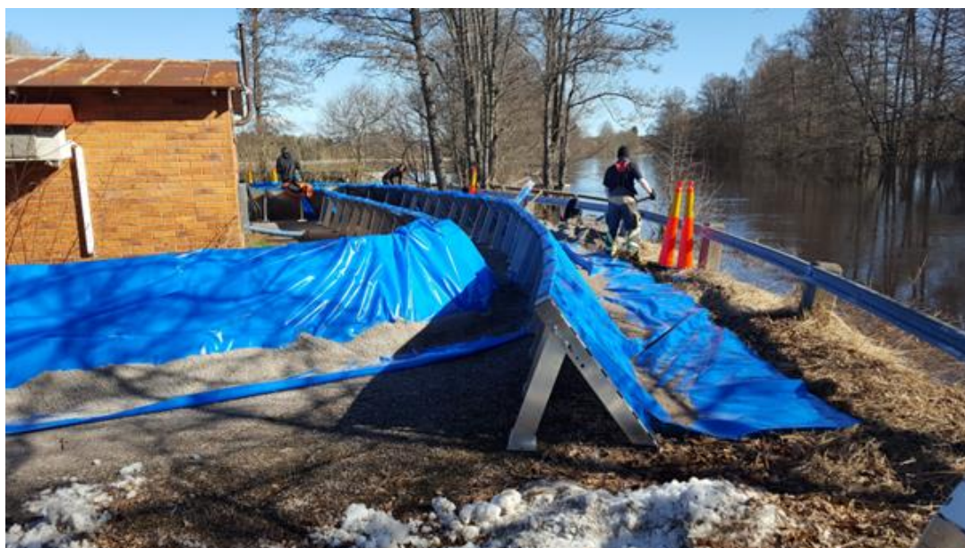
Figur 5: Bild från Gästrikke där man använder sig av aluminiumbarriärer och presenning. Bilden är tagen av Gästrikke räddningstjänst och används här med deras medgivande.
