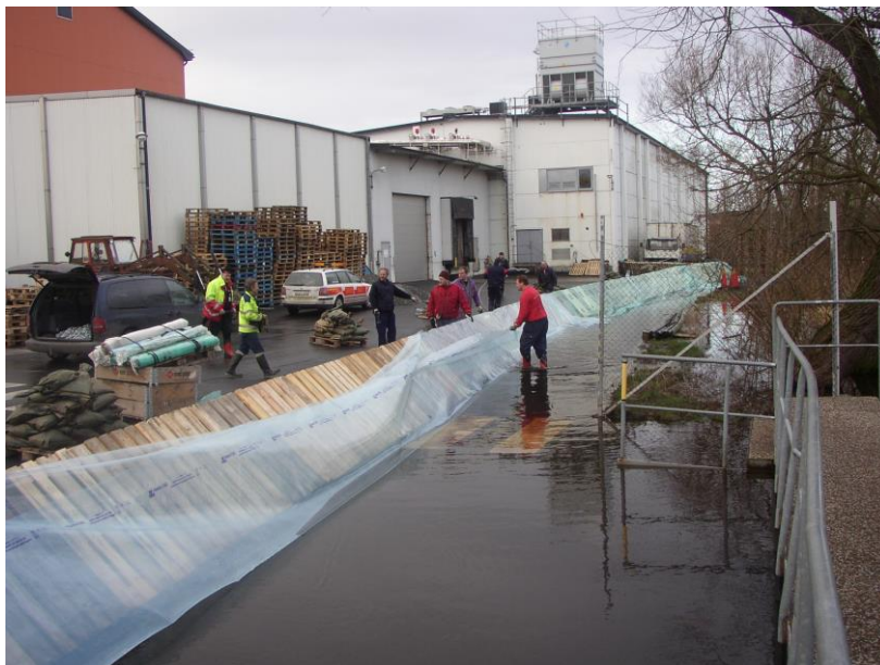
Figur 4: Bild från Kristianstad på en provisorisk barriär bestående av lastpallar och plast. Bilden är tagen av Kristianstads räddningstjänst och används här med deras medgivande.
