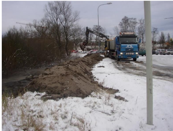
Figur 6: Bild från Kristianstad där jordmassor används som barriär. Bilden är tagen av Kristianstads räddningstjänst och används här med deras medgivande.
