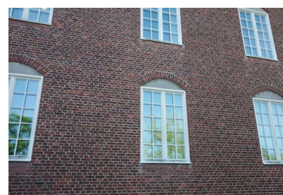
Fönsteröppningar. Ett fönster i liv med fasaden betonar fasaden yta.
