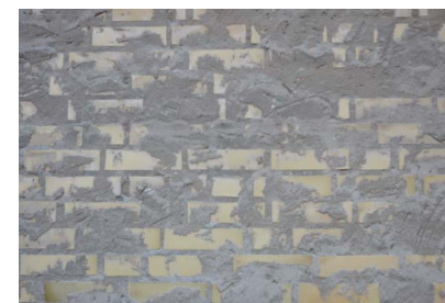
En slätskurad fog - visar muren som en yta. Också ett sätt att ge materialitet till ett billigt strängpressat tegel.
