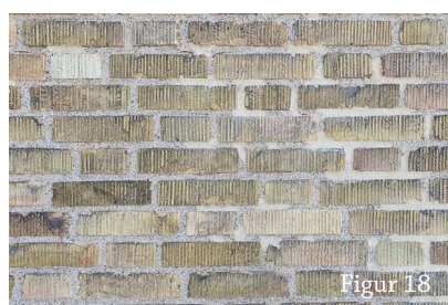
Borstat tegel. En efterbehandling av strängpressat tegel för att ge det mera materialitet. .
