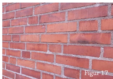
Strängpressat tegel. Totalt liket mellan stenar. Fogen grovare än stenen.
