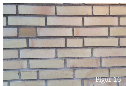
Maskinslaget tegel- mera uniformt utseende. Fortfarande naturlig variation.
