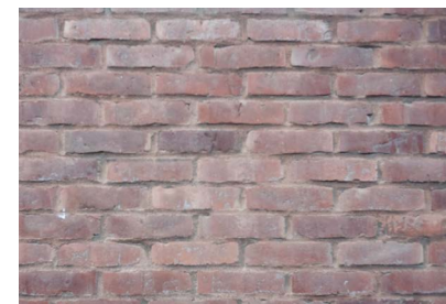
Fog i samma kulör - betonar muren som yta och textur.
