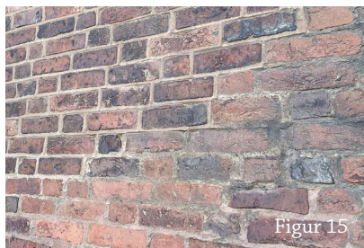
Handslaget tegel-hantverksmässighet och stor variation i form och färg.
