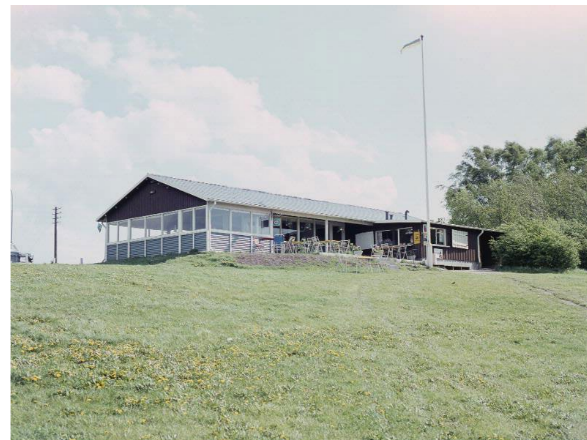
Figur 44. Cafét med uteservering, kiosk och flaggstång, 1966. Svart fasad. Till höger syns en smal upptrampad stig mot sluttningen i riktning mot havet.
