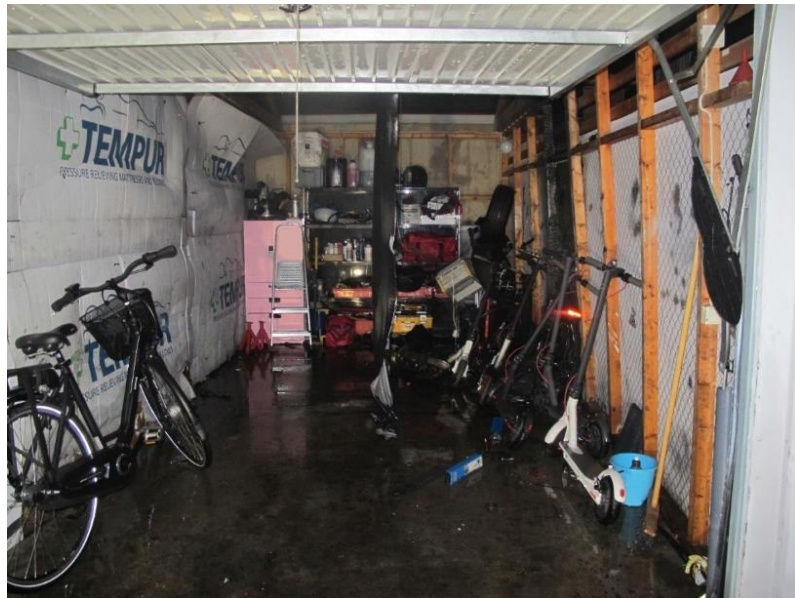
Figur 4-37. Garaget där branden startade. Elsparkcykeln som brann var vid den högra vägen i garaget.
