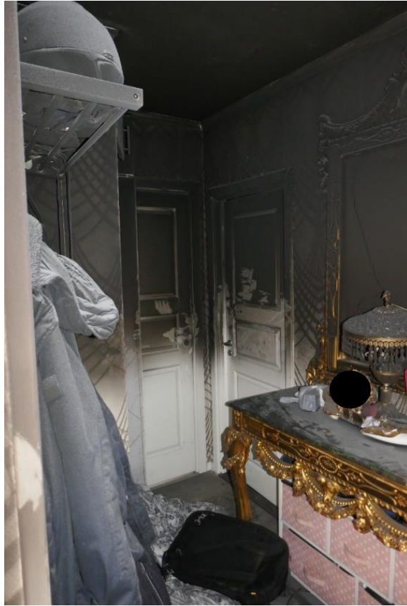
Figur 4-18, Hallen i lägenheten. Sotdeponering på övre delen av väggarna.
