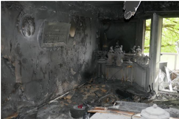
Figur 4-19, Fatbiken stod mot den vänstra väggen i vardagsrummet. TV:n och andra objekt i närheten har brunnit och smält.
