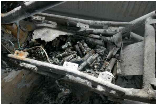
Figur 4-23. Batteriet som har brunnit inne i fatbiken.
