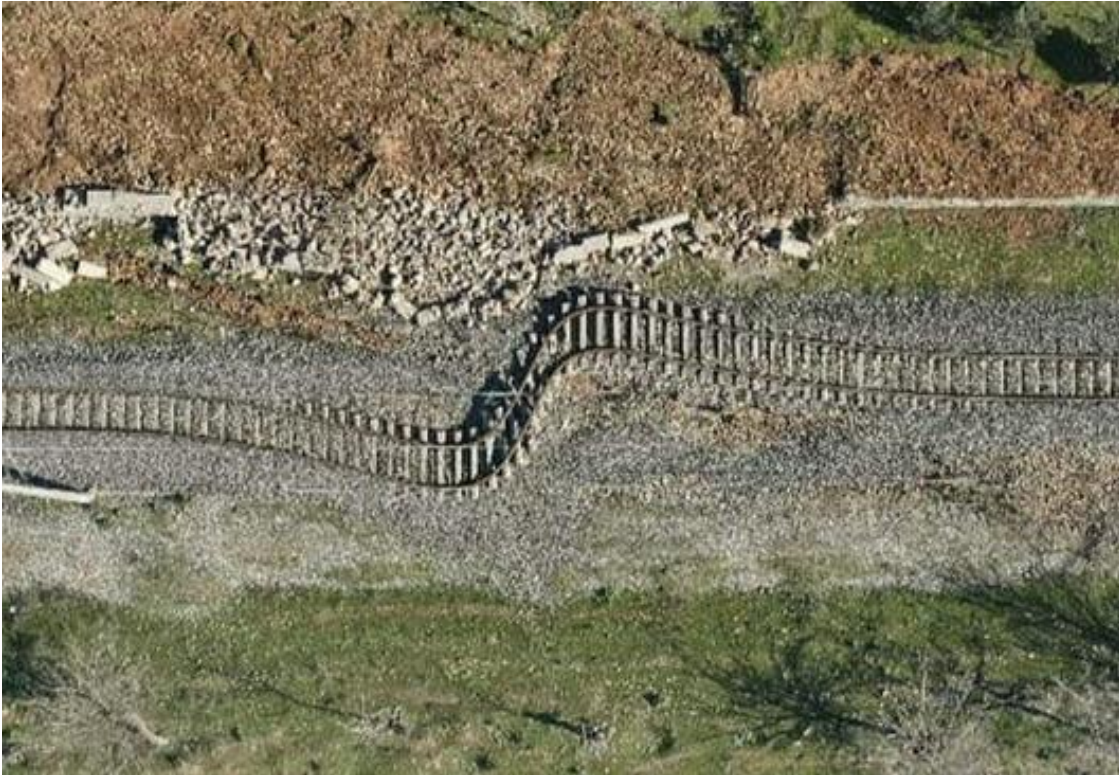
Figure 40. Lateral spreading across railway track. Image from Strateji ve Bütçe Başkanlığı (2023)
