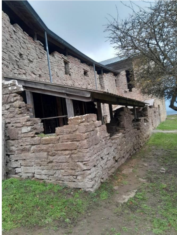
(Fig. 8. Kungshuset från nordöst, taget 21/11-2023 av Författaren)
