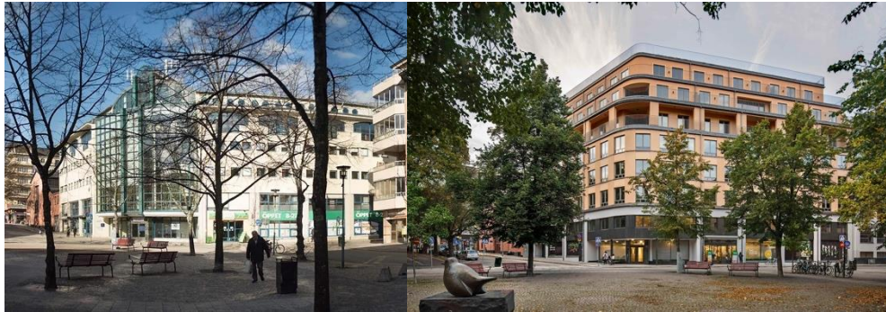
Figur 6. Till vänster visas byggnad innan påbörjad ombyggnation. Till höger visas byggnaden efter slutförd konvertering. Bilder tagna av Urban Couture Arkitekter.
