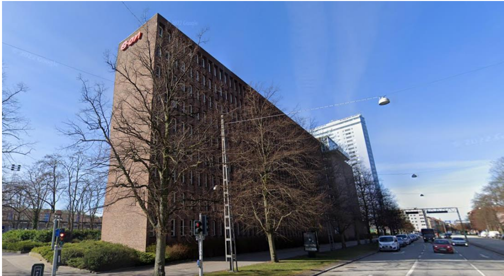
Figur 5. Fastigheten innan ombyggnation. Projektet är i detaljplaneprocess. Bild från Google Maps.
