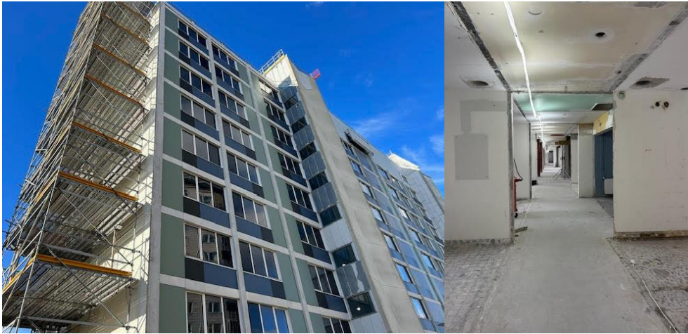
Figur 9. Pågående konvertering av byggnaden. Bilder av Brinova.
