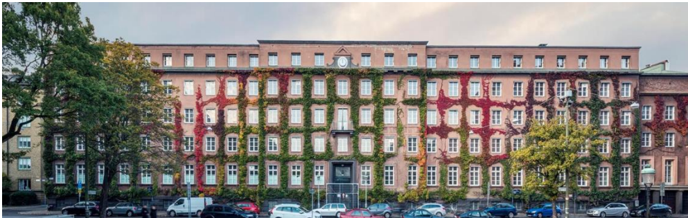
Figur 10. Byggnaden före konvertering. Bild tagen av Riksbyggen.
