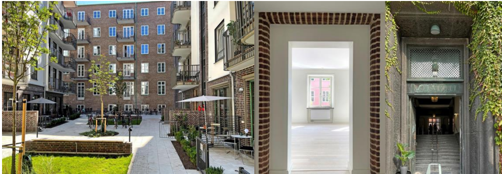
Figur 12. Till vänster, innergården efter konvertering som visar kombinationen av nybyggnation och konvertering. Till höger, originaldetaljer som har bevarats. Bilder tagna av Riksbyggen.
