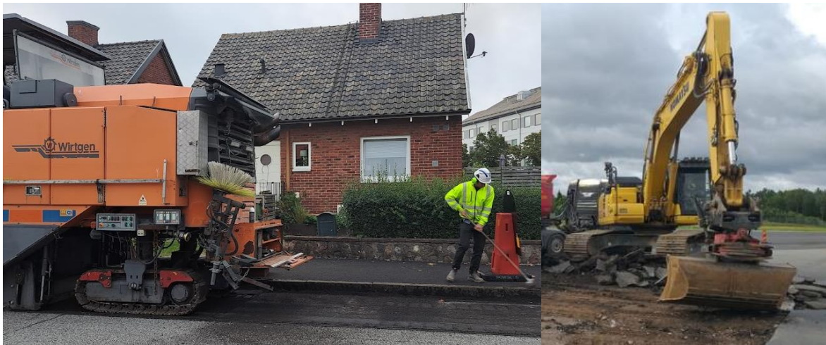
Figur 19: Pågående fräsning till vänster med Karl Negrell och grävning till höger.
