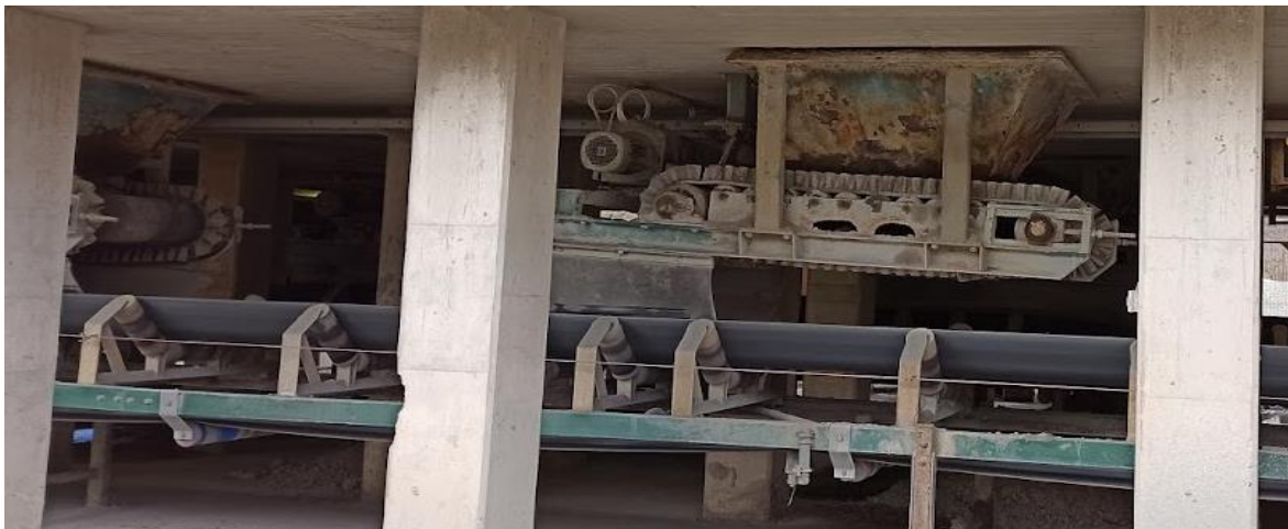
Figur 10: På bilden kan man se doseringsapparaten, det korta transportbandet samt det långa transportbandet som tar stenmaterial vidare till torktrumman.
