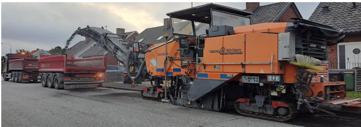
Figur 23: Fräsning av slitlagret på Ekevägen i Trelleborg.
