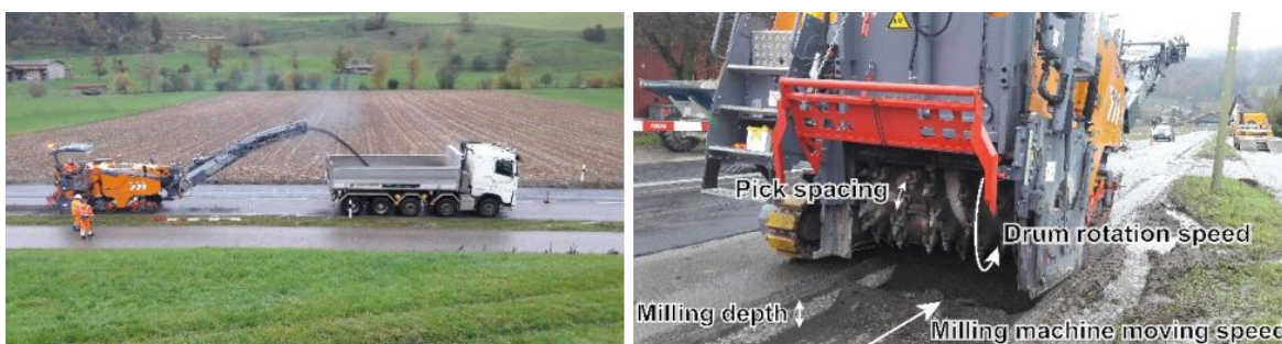
Figur 28: Fräsning och nyckelparametrar under fräsning (Zaumanis etc, 2023)
