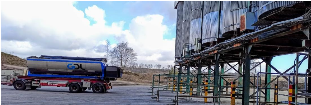
Figur 18: Upphämtning av asfaltmassa från de isolerade lagringsfickorna.
