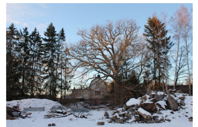
Byggarbetsplats (Egen bild, 2023)
