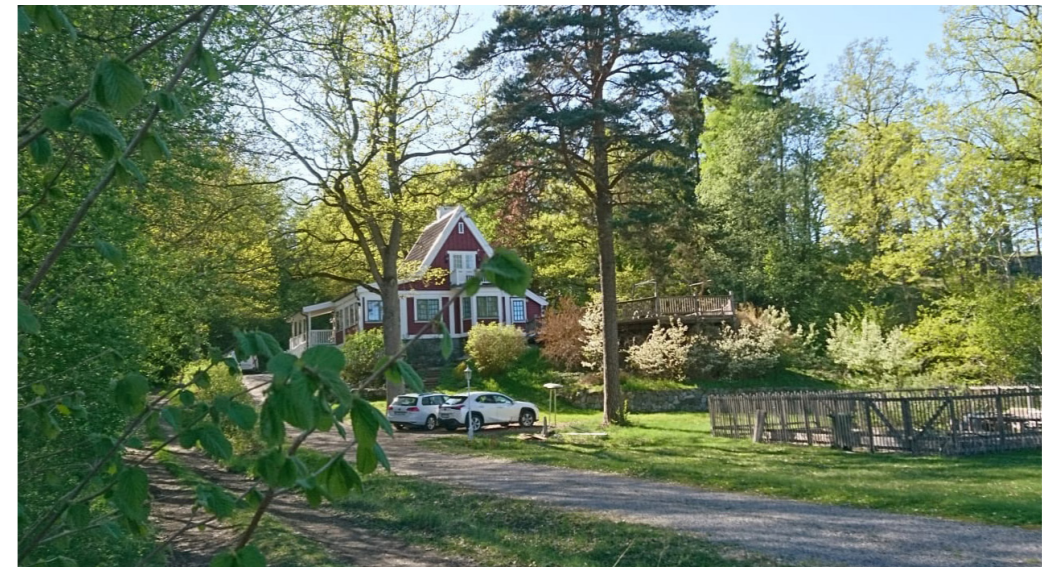
Stigberga, även kallat Pepparkakshuset (Egen bild, 2023)
