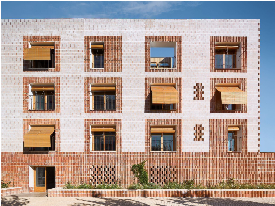
Husets gatufasad med traditionella solskydd framför fönsteröppningarna och mönstersatta luftintag. Bildkälla: Pol Viladoms (u.å., egen beskärning)
