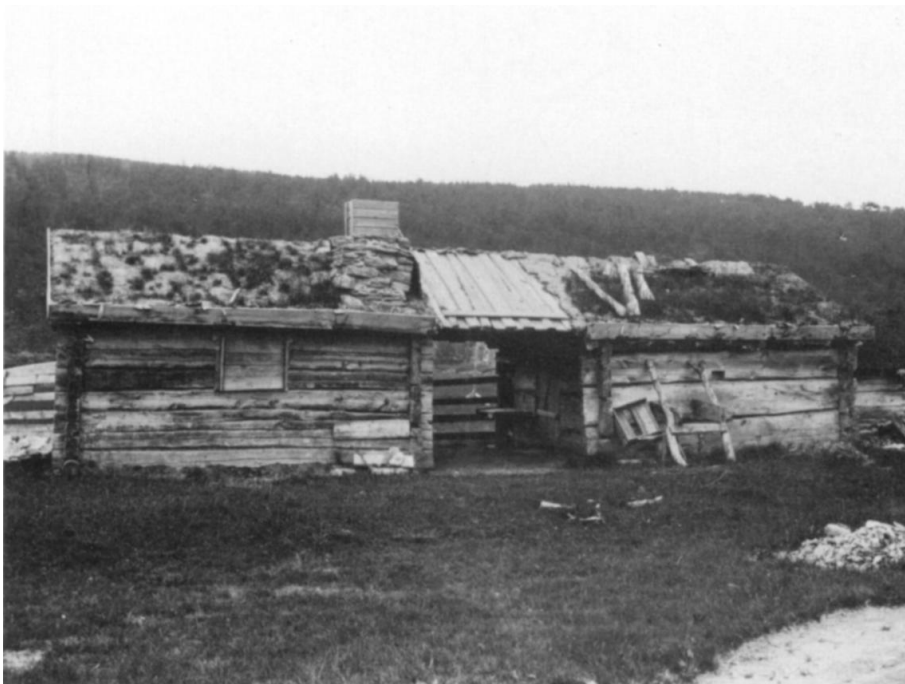
Byggnad med "dog-trot"-utseende i Tännäs socken, Härjedalen, nära den norska gränsen 1920. Planen är typisk för en säsongsbostäd för en sommarherde i dessa trakter, med en bostadsdel på vänster sida av passagen och en boskapsdel för kor till höger. Bildkälla: "Nordiska Museet, Stockholm, No. 70Grn" i Jordan & Kaups 1987, s. 66 (egen beskärning)
