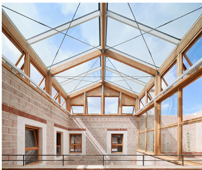
Det slutande glasskalet till en av byggnadens fyra atrier, med vädringsfönster åt sidorna för passiv ventilation. Bildkälla: Pol Viladoms (u.å., egen beskärning)
