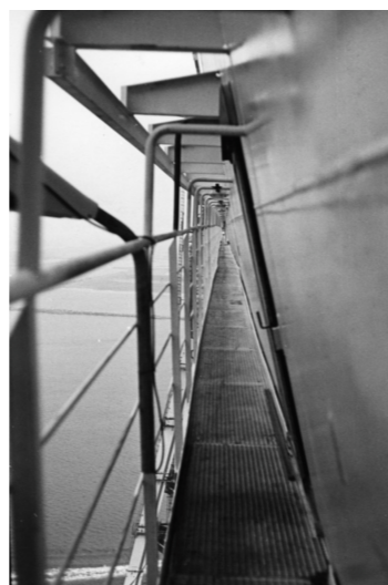
Gång längst med kran
