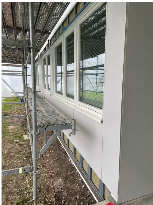
Figur 3.27 Utfackningsväggarna med delar av fasadskivorna monterat.
