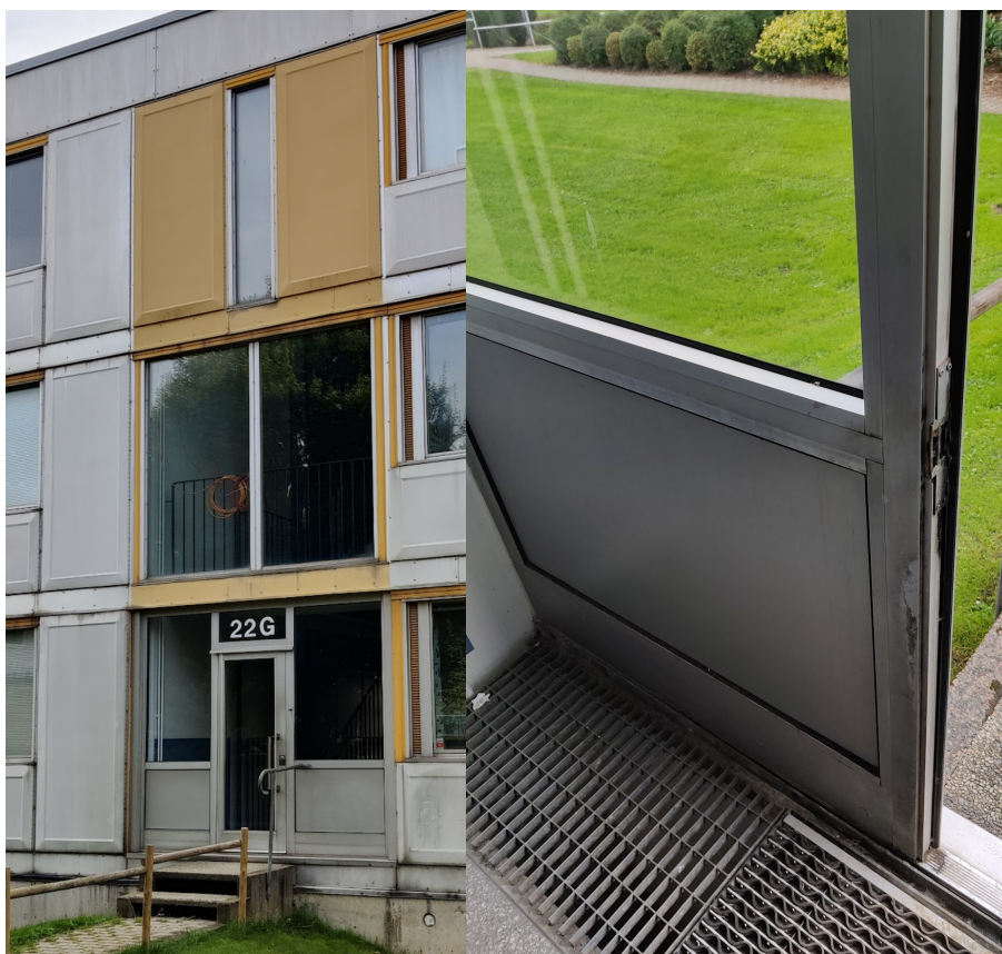
Figur 3.10 Figuren visar två bilder av trappuppgångarna före renoveringen: En utifrån (t.v.) och en inifrån (t.h.). Dessa är försedda med 2-glasfönster i aluminiumprofiler.
