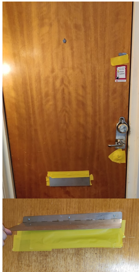
Figur 4.4. Tätning av medvetna öppningar, så som brevinkast och nyckelhål på ytterdörrarna ut mot trappuppgångarna, tejpades på detta sätt igen.
