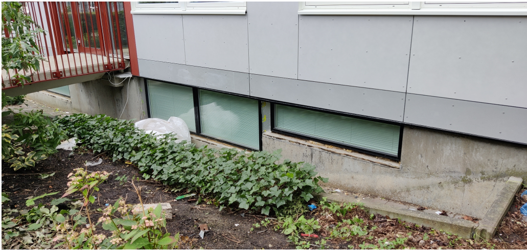
Figur 3.24 Bild på nästintill färdiga källarytterväggar där fönsterbyte gjorts och ny isolering mellan dessa installerats. Dock har den yttersta fasadskivan inte installerats än och PIR:en är synlig.
