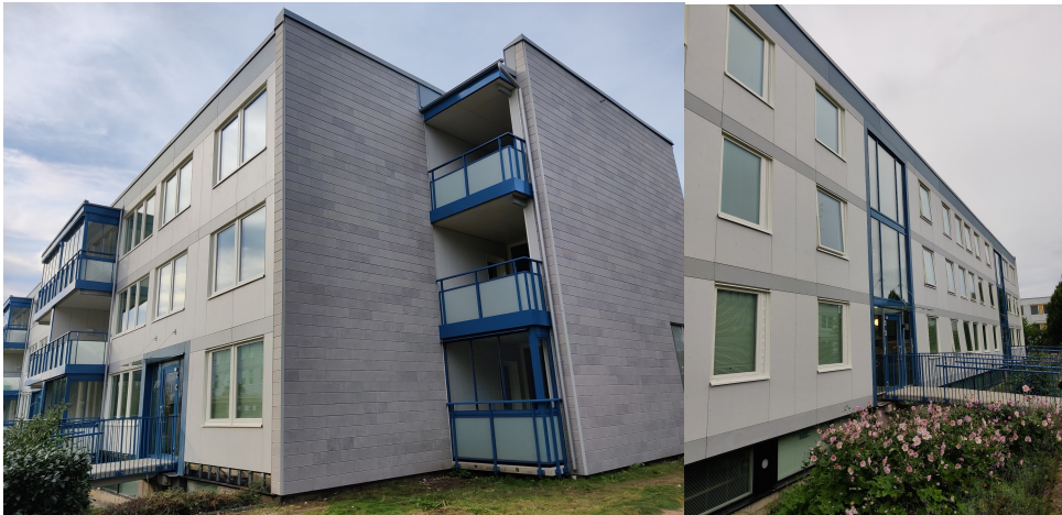
Figur 3.16 Exempelbild på hur ett färdigrenoverat hus ser ut. I detta fall visas hus 20 (t.v) och hus 16 (t.h.). Samtliga hus ser dock likadana ut med undantag av färgdetaljerna på balkonger och räcken där de olika gårdarna har olika färger.
