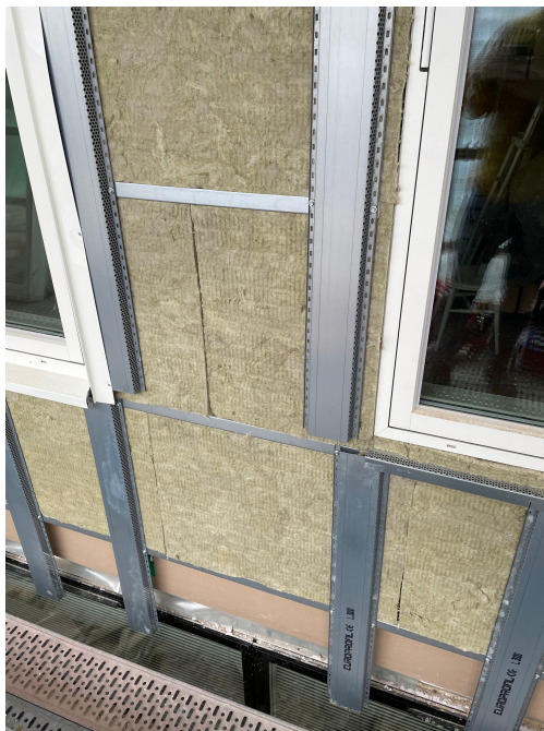
Figur 3.26 De nya utfackningsväggarna med isolering, stålreglar, fuktspärr, vindskydd och fönster monterade på plats - efter en dags arbete.
