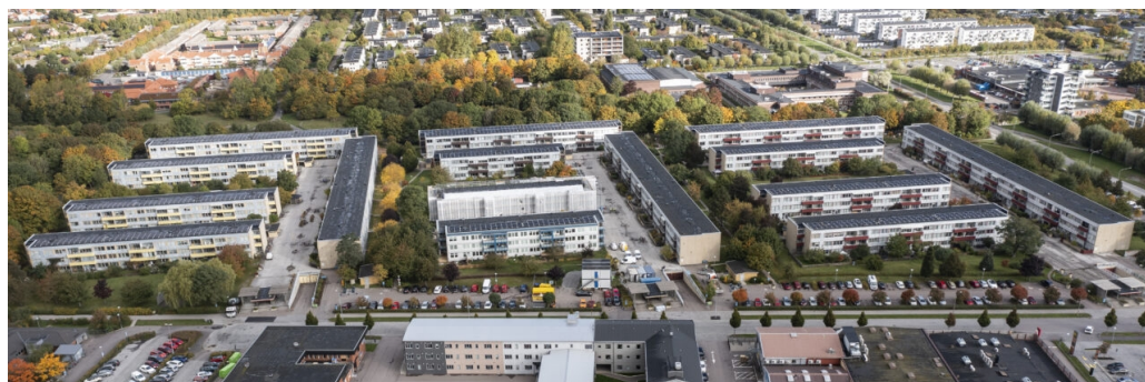
Figur 3.2 Flygbild över området under renovering av hus 16 (Servicekuben u.å.).
