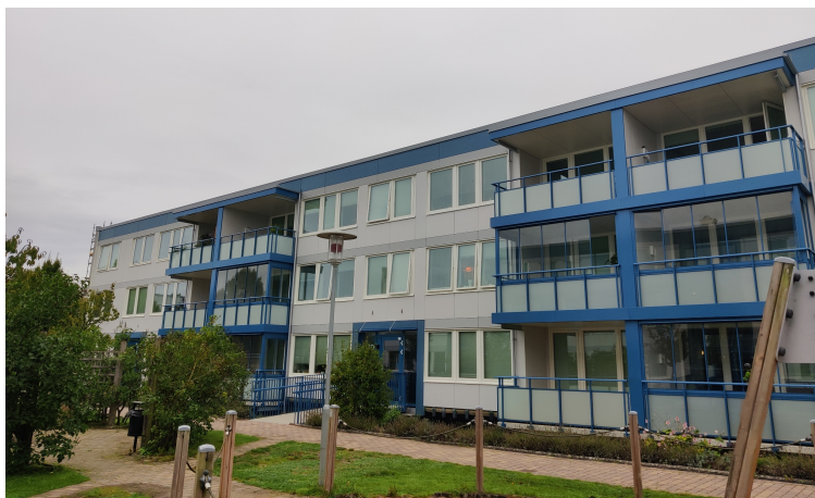
Figur 3.28 Färdigt resultat av renoveringen, på bilden syns Hus 20.
