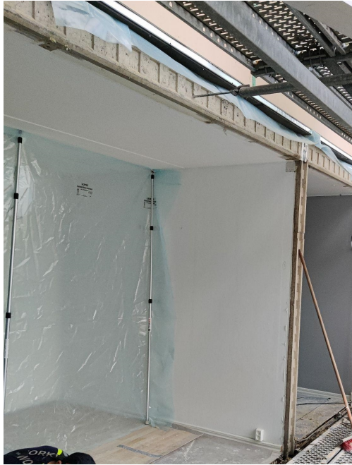
Figur 3.25 Visar stadiet då den gamla utfackningsväggen monterats ner och lägenheten har avskärmats mha. plast - detta under tiden då montage av nya väggar pågår under en arbetsdag.
