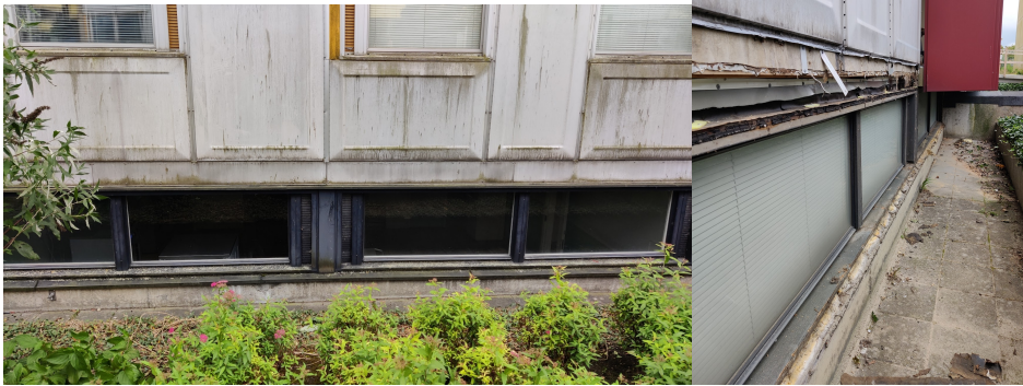
Figur 3.8 Figuren visar långsidorna där källarytterväggen är exponerad ut mot fria luften med källarfönster och landgångar över till trappuppgången. Varje hus har källarfönster på detta sätt längs med en av sina två långsidor.
