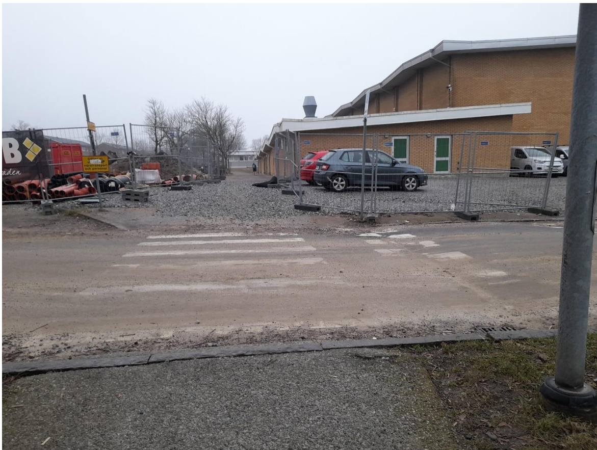
Figur B3: I fotot ses övergångsstället till skolan över Sockenvägen, precis till höger kan farthindret ses. Till vänster är byggarbetsplatsen där den gamla skolan rivits, till höger är byggparkering och idrottshallen och längst bak är de tillfälliga barackerna för årskurs ett till tre. Bild tagen av Bengtsson 2024.
