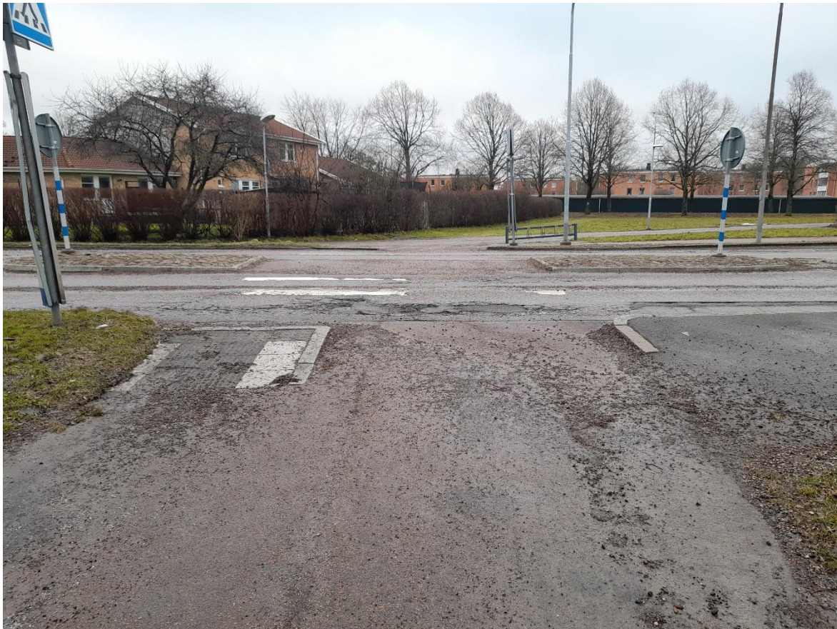
Figur B22: I fotot ses övergångsstället över Sallerupsvägen vid observationsplatsen. Platsen har ingen fartsänkande åtgärd, men har en mittrefug. I övrigt kan också konstateras att underhållet av platsen verkar bristfällig över vägbanan. Bild tagen av Bengtsson 2024.
