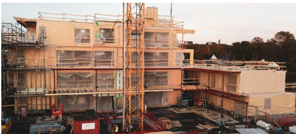
Figur 13. Plastskydd monterat som skall runt stommen (Boman, 2024)
