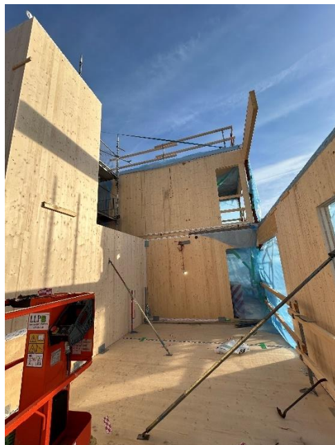
Figur 11. Lyfter KL-träelement på plats och stag som håller upp vägg vid montage (bild till höger från Boman, 2024)
