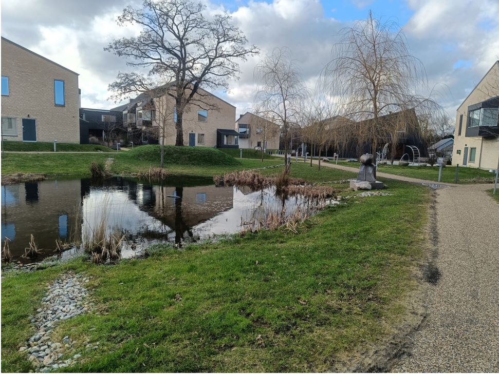
Figur 6.3: Allt dagvatten hanteras inom fastigheten sedan byggnationen av ålderdomshemmet Holmegårdsparken i Ordrup. Därför behövde aldrig någon anslutningsavgift betalas.
