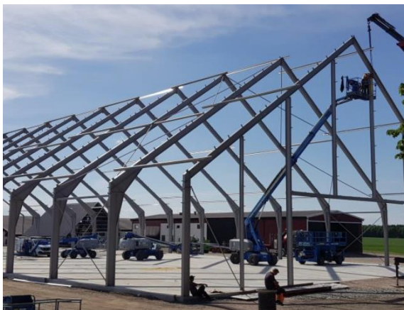
Bild på en stållhall under konstruktion.
