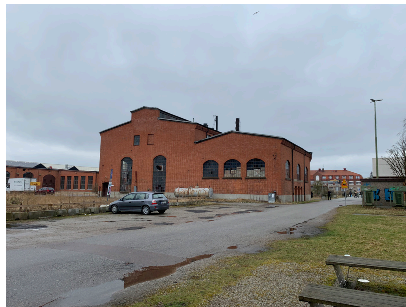
Ångcentralens södra fasad
