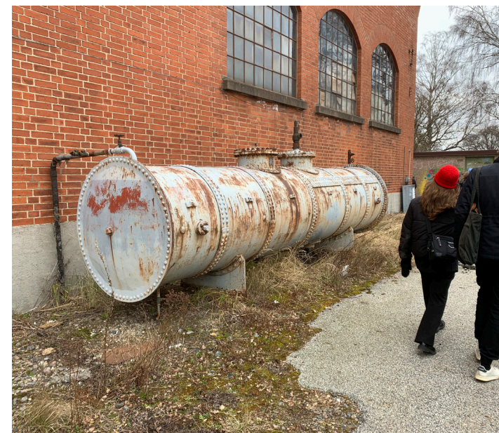
Nitad tank på ångcentralens södra sida
