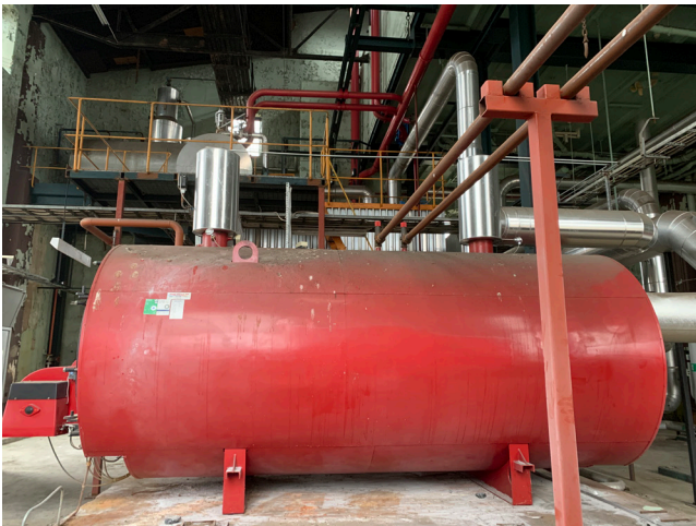
Bild på hur den befintliga pumpen ser ut.
