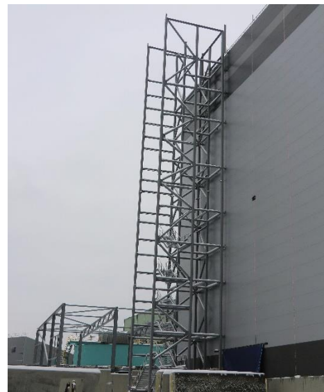
Figur 1.2. Utanpåliggande industritrapporn under byggnation. Bild hämtad från Sweco.
