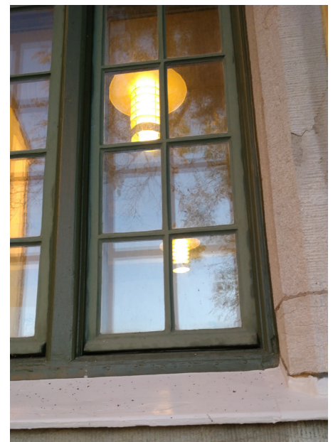
Fönster västerut från rum 209/turistbyrån sedd från innergården. Karmen är målad men bågar har ännu inte påbörjats. Vid målning av karm har bågar blivit fläckiga av den nya färgen.
