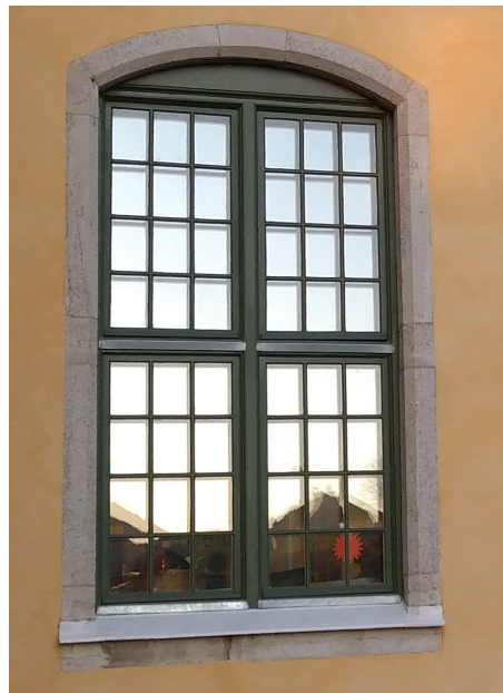
Västra fönstret i södra mittpartiet av byggnaden (rum 209/turistbyrån) efter avslutad restaurering.
