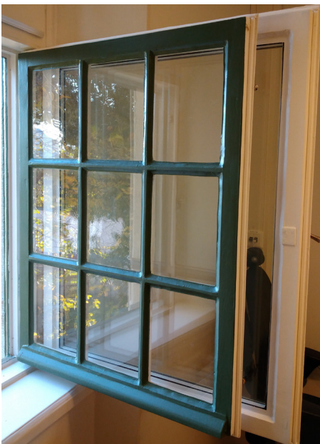
Exempel på nyrenoverat fönster inifrån med bågar frikopplade och.
