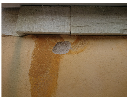
Fukt/frostskada under fönster
