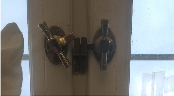
Västra fönstret i rum 2019 (turistbyrån) innan byte av låstappar.
