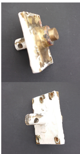
Del av koppling som ger skador i ytterbåge
