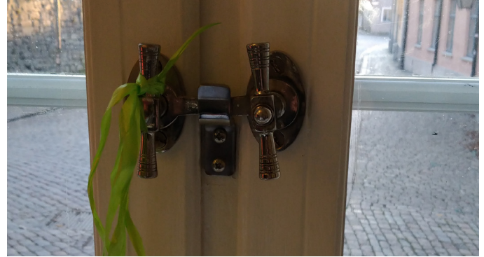
Samma fönster efter byte av tapp. Utformningen av tappen fungerar bra men skruv behöver bytas till spårskruv lika de på låsvredet.
