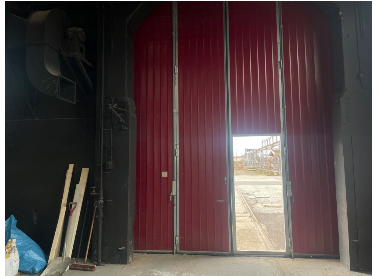
Bild 8. Dörr in till hjulverkstaden.
