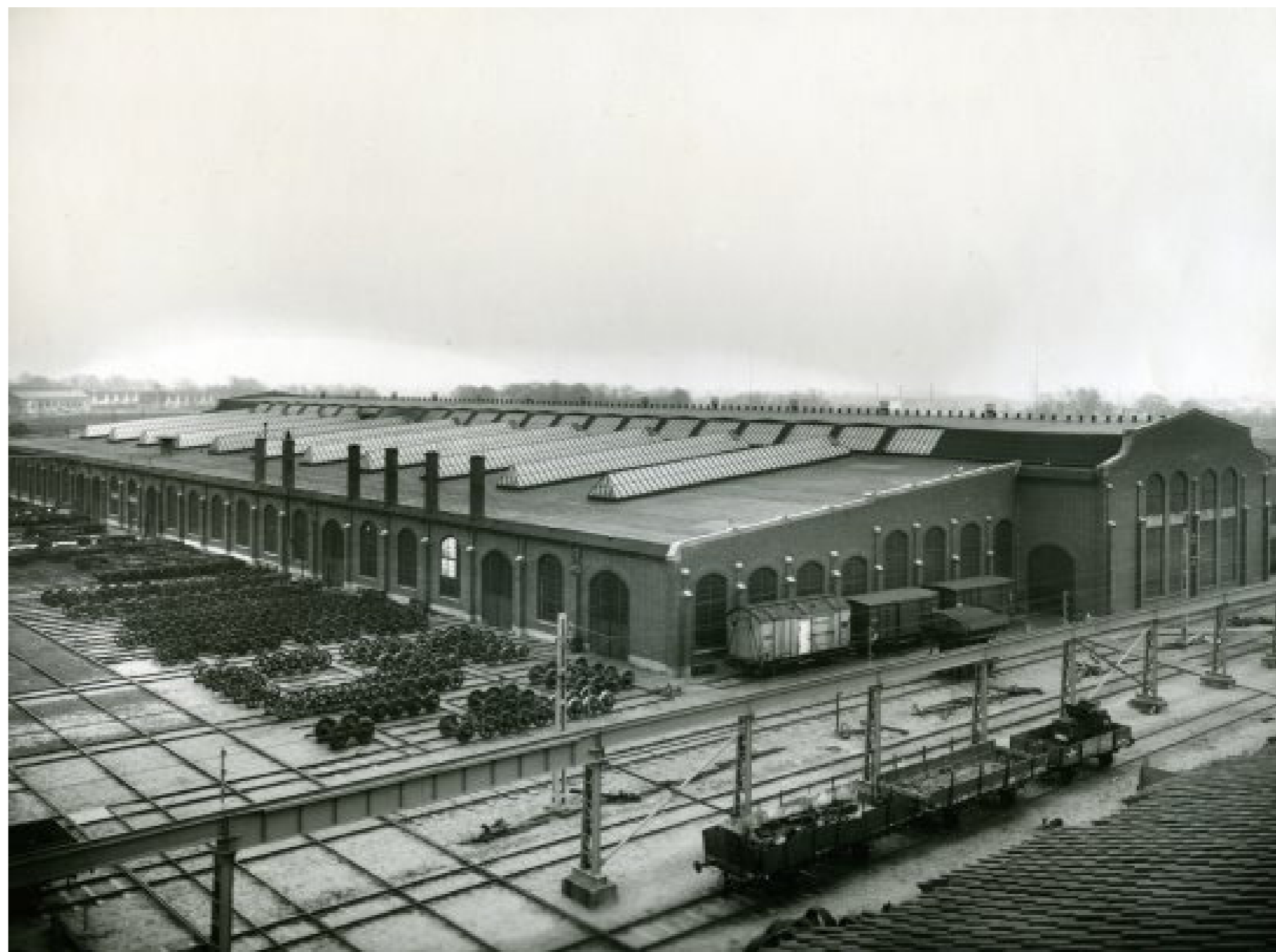
Bild 1. Historisk bild av Lokstallarernas vagnverkstad.
