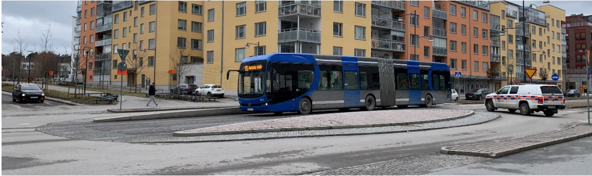
Figur 43: Exempel på utformning där bussen kör genom en cirkulationsplats. Fotografiet är taget längs med Barkarbyvägen, Järfälla.
