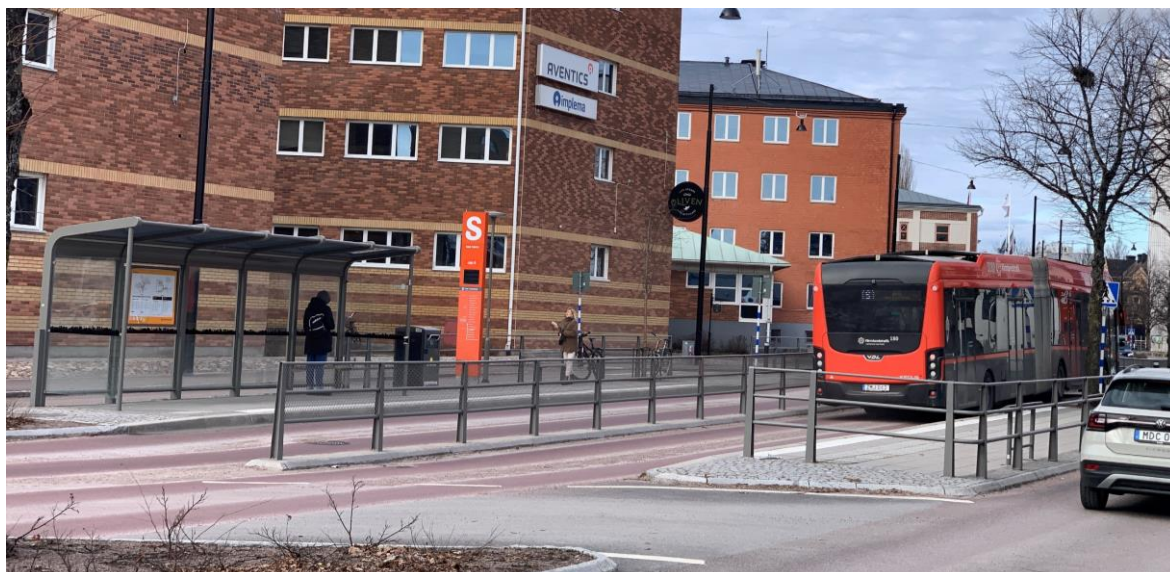
Figur 49: Fotografi på en mittplacerad stopphållplats. Fotografiet är taget på hållplats Inre hamn, Karlstad.
