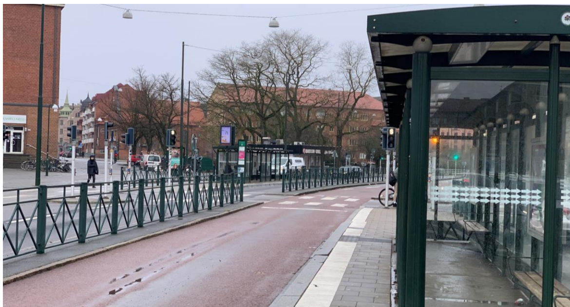
Figur 15: Stopphållplats med mittförlagt, visuellt markerat busskörfält. Fotografiet är taget på hållplatsen Folkets park, MalmöExpressen linje 5.
