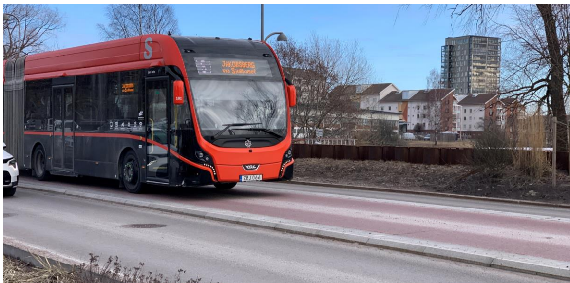
Figur 27: Mittförlagt, fysiskt separerat busskörfält, där separering sker genom en förhöjning av körfältet. Fotografiet är taget längs med Sjömannsgatan i Karlstad.
