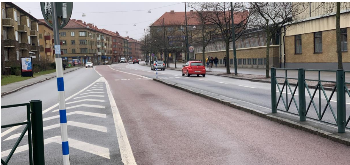
Figur 44: Mittplacerat busskörfält som är visuellt avgränsat. Fotografiet är taget längs med Amiralsgatan, Malmö.
