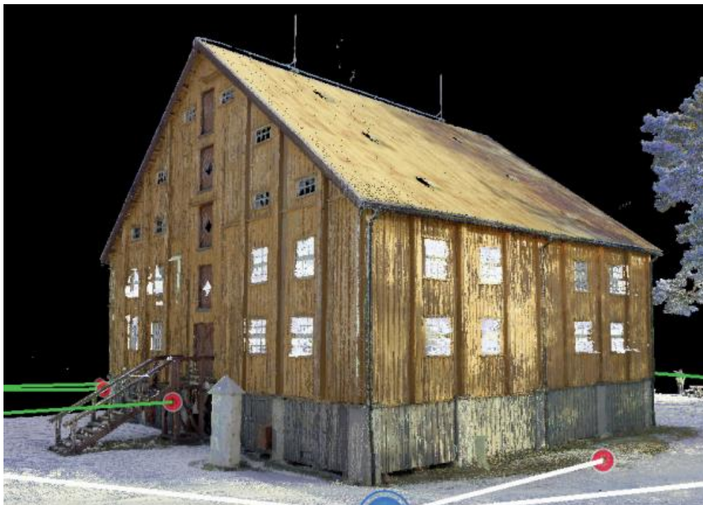
Fig. 19 Inskannad "digital twin" av befintlig byggnad (SirkTRE 2023),
