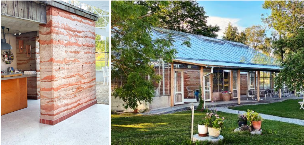
Figur 13a: Närbild på den stampade lerväggen (Kloka hem 2021).
