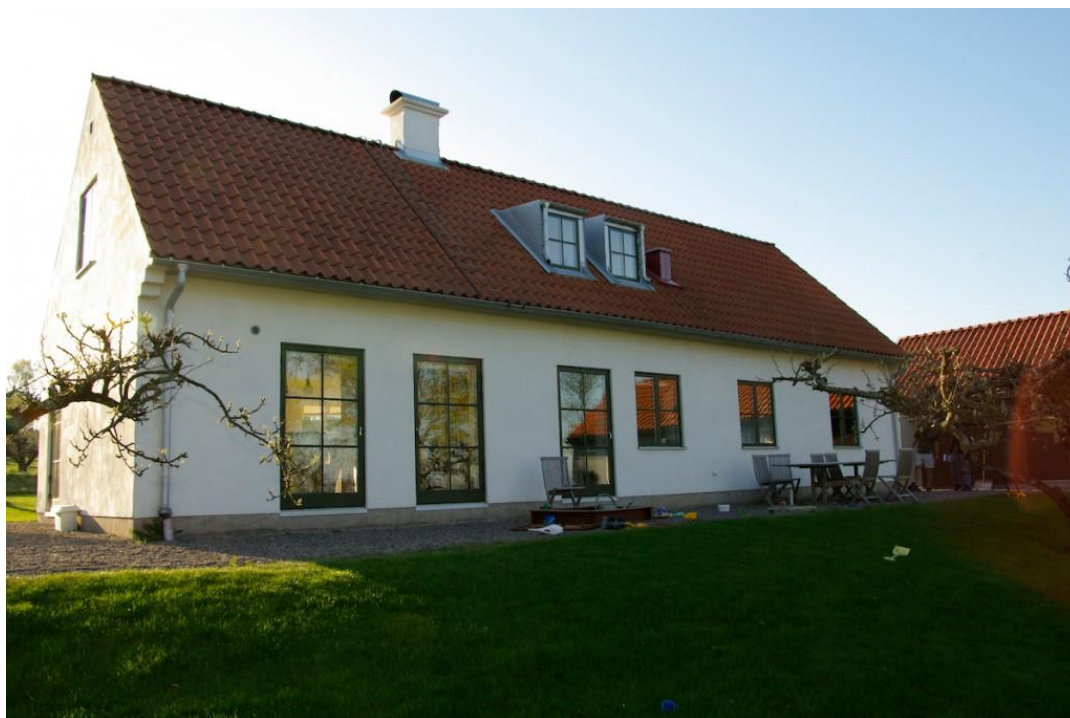
Figur 10: Ett av de stampade lerhusen i Steninge som uppfördes på 90-talet (Bülow 2009).
