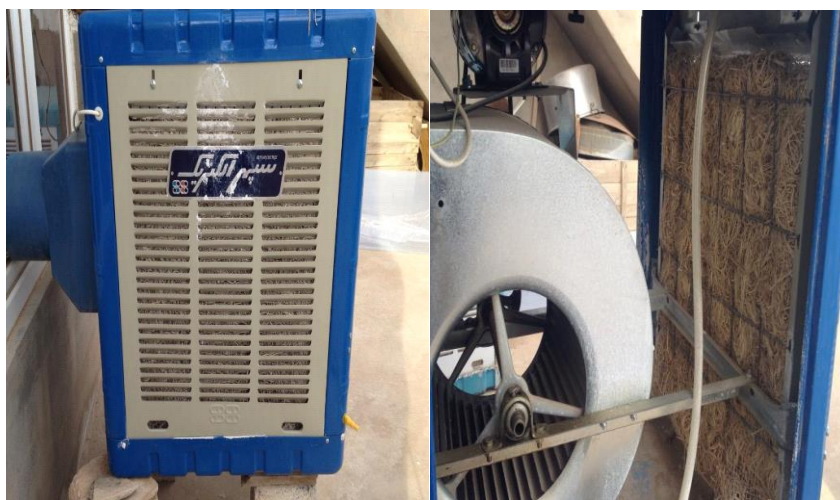
Figur 4.2 En kylmaskin som har placerats på altanen, bilden till vänster visar utsidan och bilden till höger visar insidan av maskinen.
