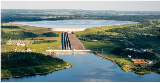
Figur 1: Bild över en typisk Vattenpumplagring 1
