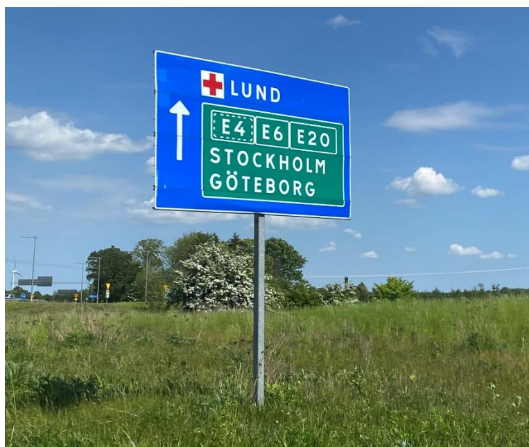
Figur 2-1 En centrumplacerad vägskylt tillverkad av aluminium på en bärande KKR-stolpe. Foto: Ida Liljeqvist
