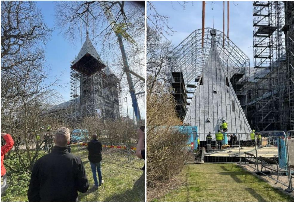
Bild I visar tornaket på väg ned. Till höger strax innan taket landar på ankringspunkterna. Byggarbetare är på väg in genom luckan för att kunna styra in takhuvan till sin position. Inhämtat från en privat rapport.
