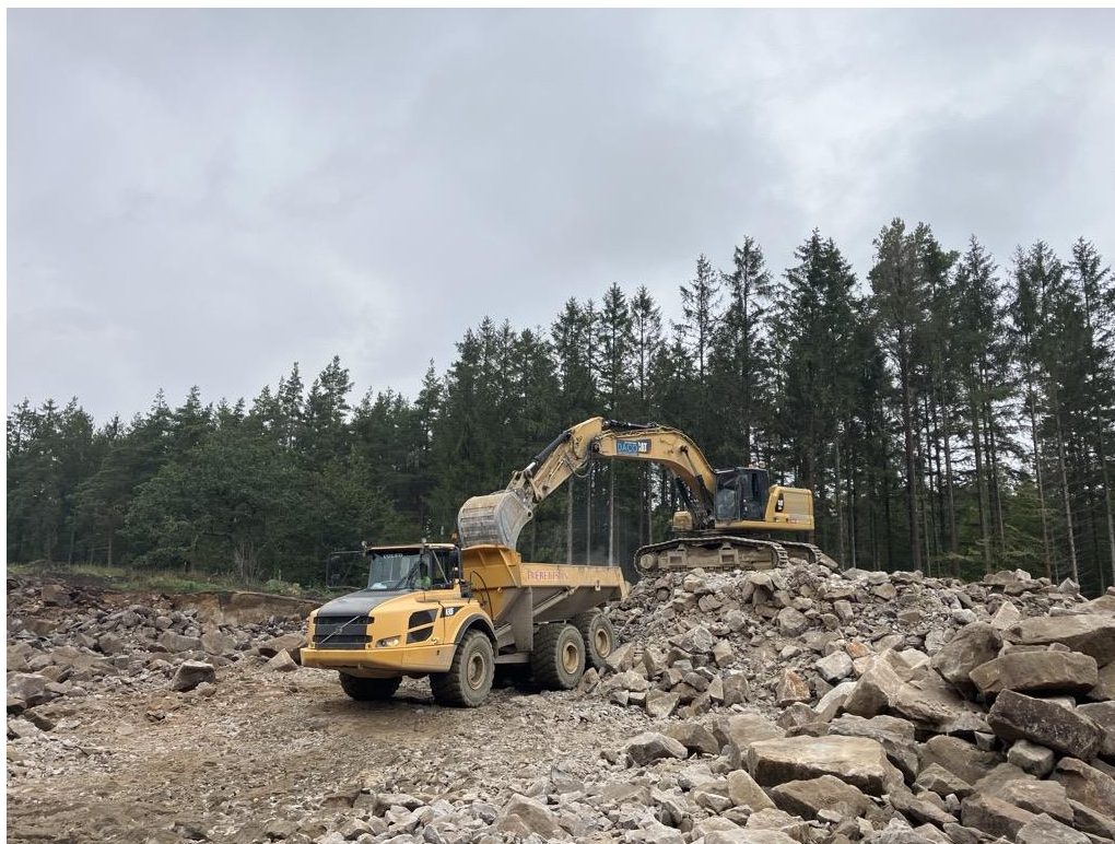
Figur 2.1 Schaktning av sprängmassor, E22 Lösen-Jämjö (Källa: egen bild)
