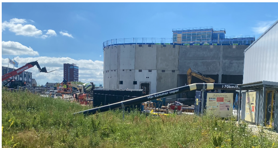
Figur 4: Bild från fältobservationen på rörledningen som ansluter til terminalen.
