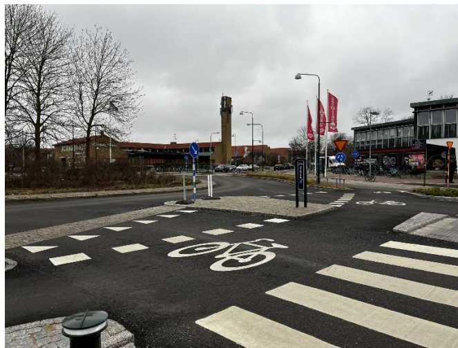
Figur 6.21 - Cirkulationsplats med separata överfarter, Erikslustvägen-Köpenhamnsvägen, Malmö
