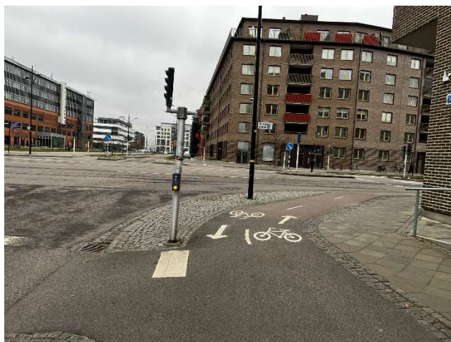
Figur 6.16 - Cykelbana mot signalreglerad cykelpassage, Lilla Varvsgatan-Östra Varvsgatan, Malmö
