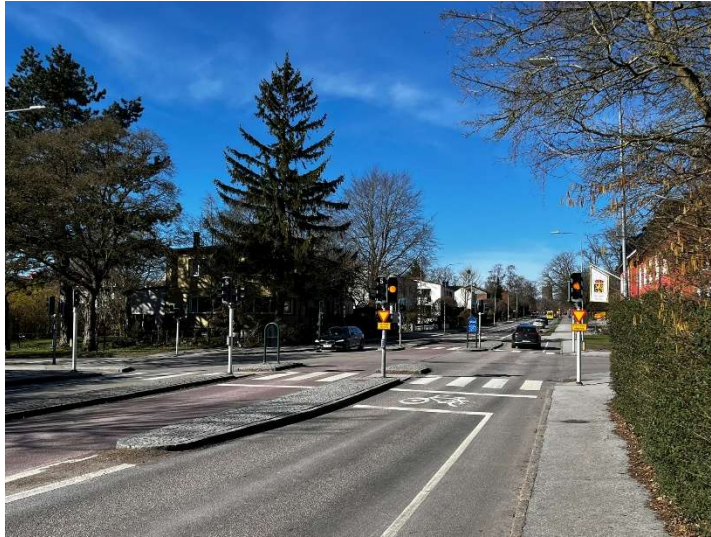
Figur 6.5 - Korsning med cykelbox från Tornavägen-Östervångsvägen, Lund
