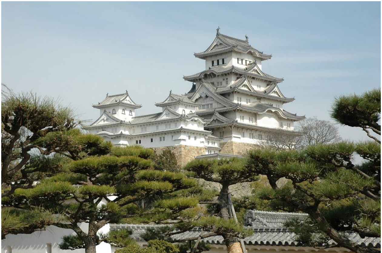
Figur 27. Himeji slottet byggdes år 1609 under Azuchi-Momoyama-perioden som ett militärt försvarsverk och maktsymbol. Dess smarta träkonstruktion och stenfundament har hjälpt slottet stå emot både jordbävningar och bränder i över 400 år. Foto: Jamie Barras Källa: Wikimedia Commons
