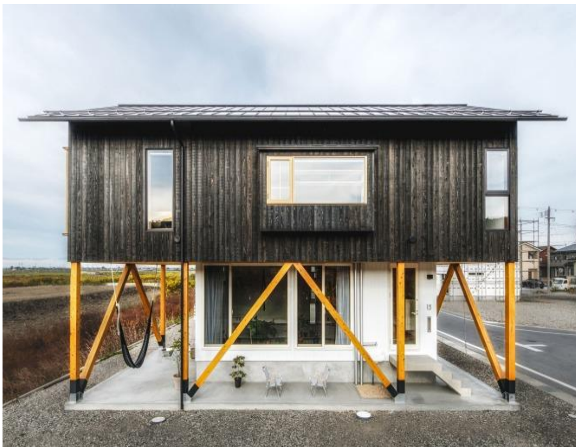
Figur 1 En resilient design av Ushijima Architects i Irie, Japan "U House", för hantering av de återkommande vattenflodattackerna från Biwako sjön. Foto: Shinya Tsujita. Källa: ArchDaily
