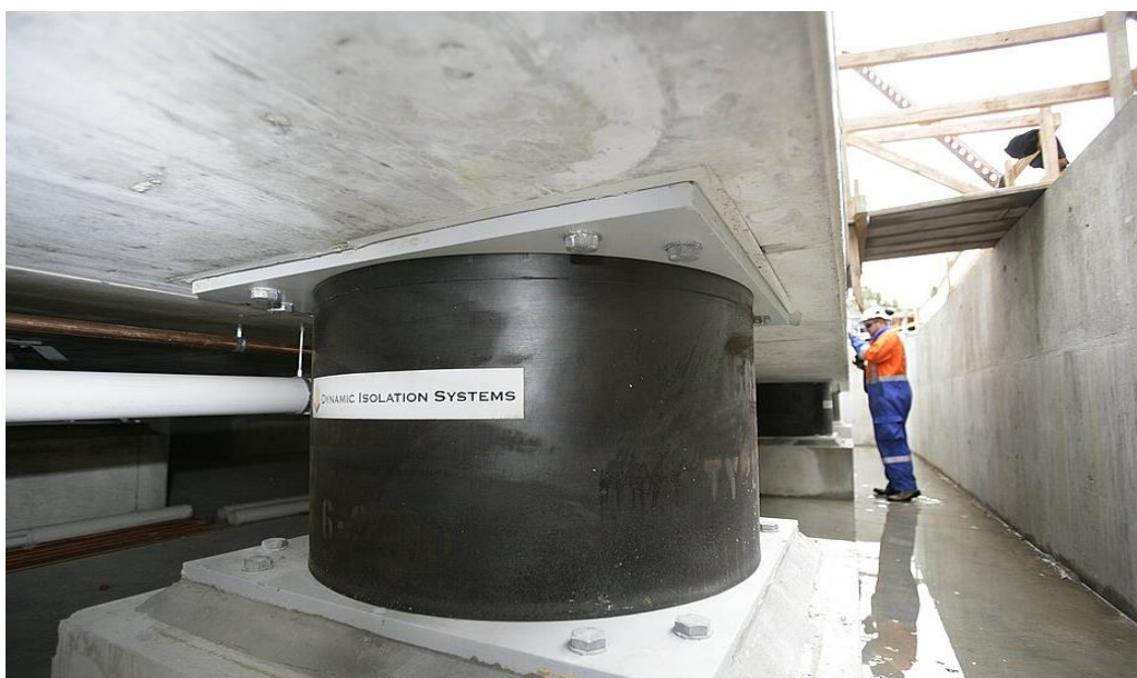
Figur 34. Basisoleringsdämpare för seismisk skydd. Foto: Marshelec. Källa: Wikimedia Commons.
