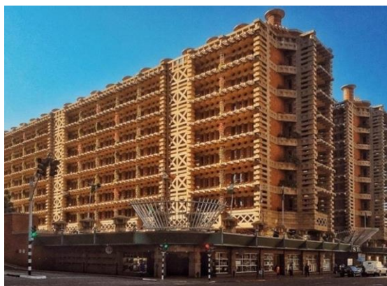
Figur 10. Eastgate Centre i Harare, Zimbabwe, vars arkitektur inspirerat av termitstackars ventilationsprinciper för minskad energiförbrukning och förbättrad klimatkomfort. Källa: Re-thinking the Future .
