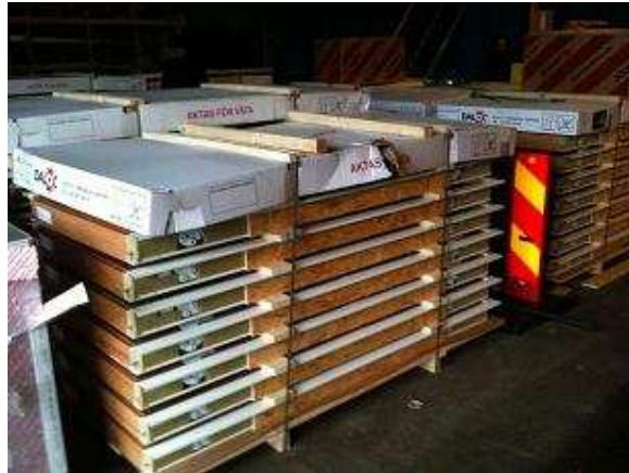
Figur 4.3 Mellanlagring av dörrar. Trapphusvis sorterade. 182
