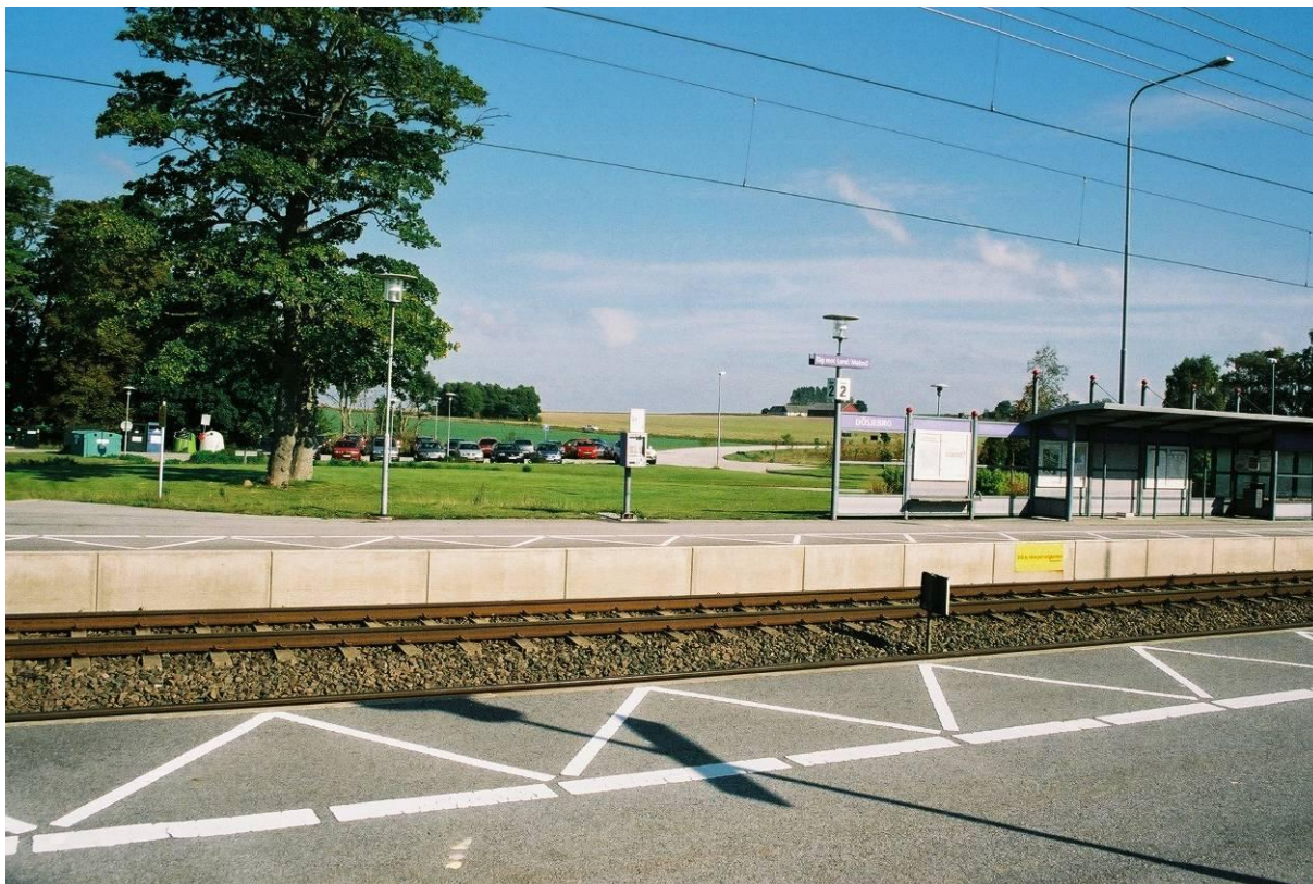
Figur 10. Dösjebro station har 559 resenärer per dag. Stationen har endast anslutning till Pågatågen mellan Malmö och Ängelholm. Orten har 847 invånare.
