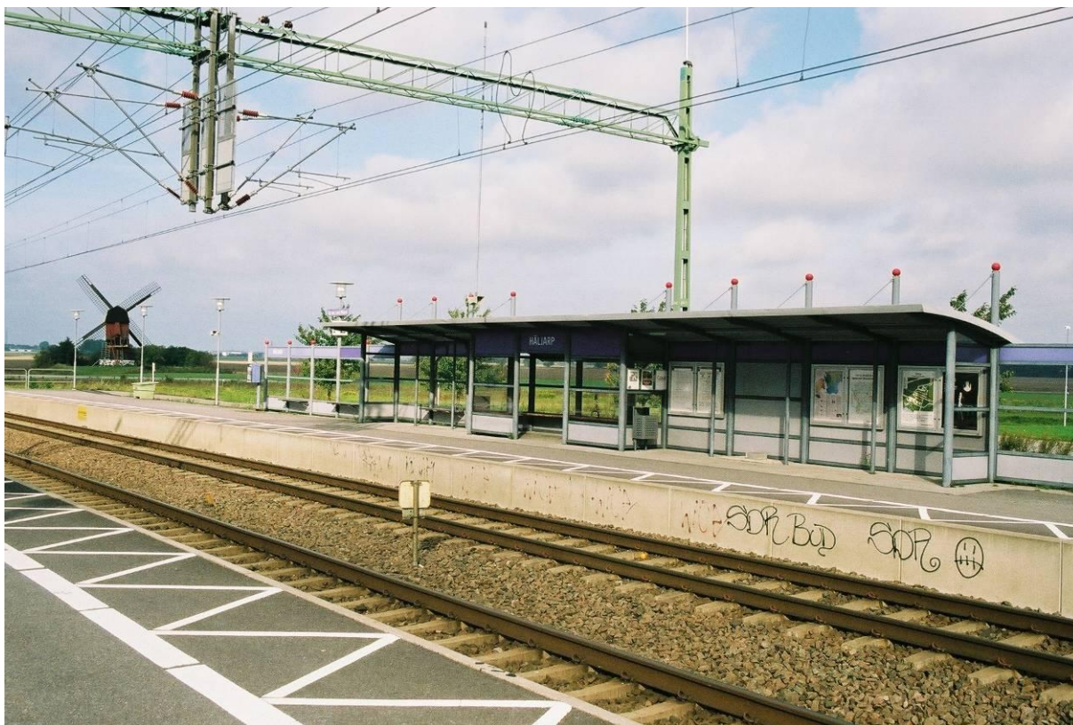
Figur 8. Häljarps nya tågstation har 493 resande per dag och orten har 2818 invånare. Tågförbindelserna utgörs endast av Skånetrafikens tågtrafikförbindelser mellan Malmö – Ängelholm.
