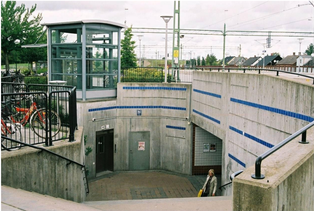
Figur 2. Riktiga gångtunnlar till yttre spåren och en väl fungerande hissanordning för funktionshindrade, servicefordon och barnvagnarna gör stationens funktion bättre. Kävlinge järnvägsstation.
