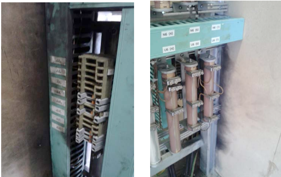
Figur 13: Sönderbrända plintar och spolar (Foto: Nielsen, M. 2012)
