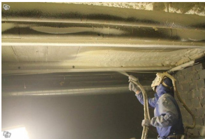
Figur 1: Installation av sprayskum i krypgrund på Revinge Garnison.
