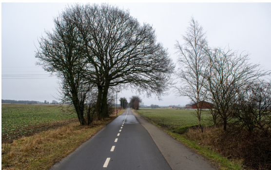
Image 2 - Unpaved sidewalk on Hardebergaspåret
