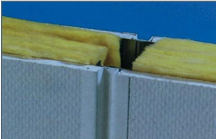
Bild 8 42 Vanligaste typ av flexibel vägg med stålregel, mineralullsisolering, målad glasfiberväv samt inredningsskena mellan skarvarna.
