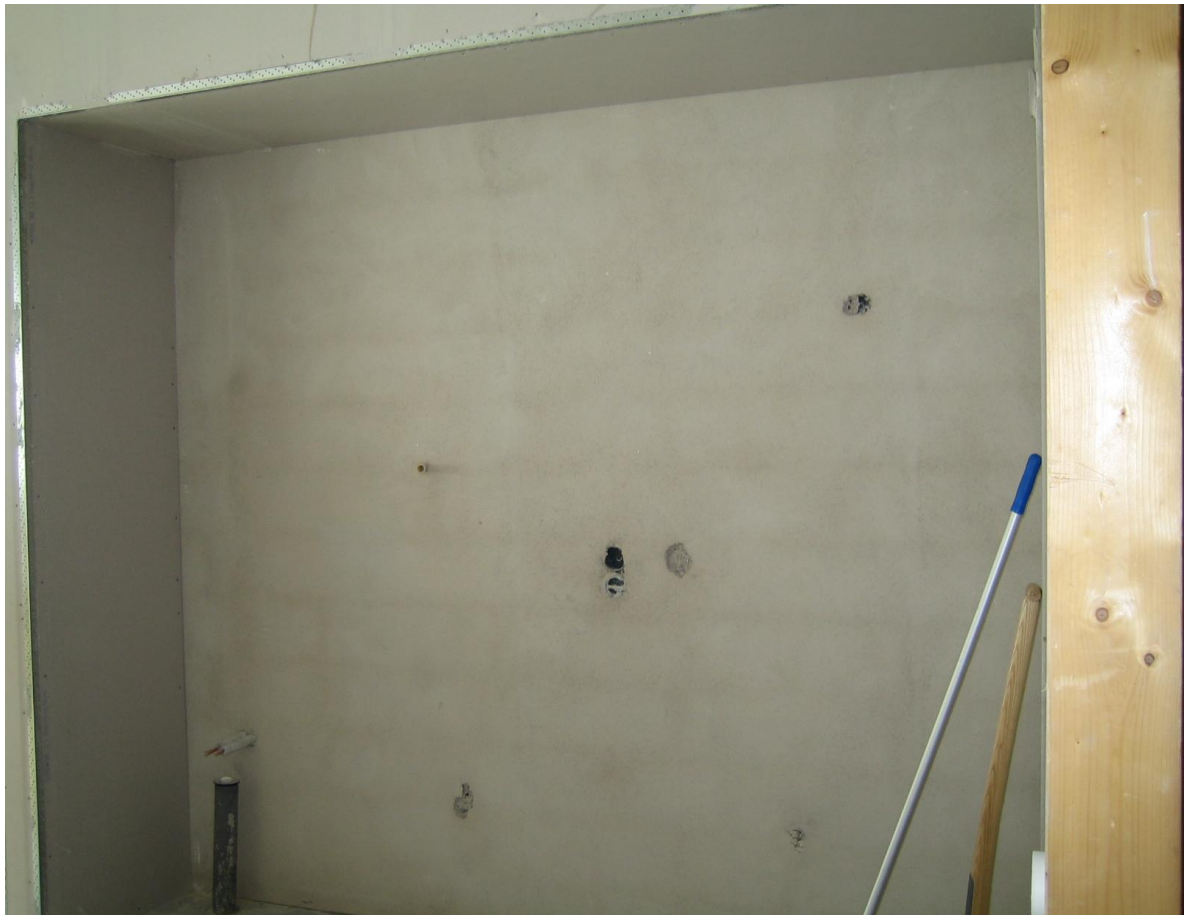
Bild 7 40 Våtrumsväggar är delvis teknisk förbered för framtida badrum.
