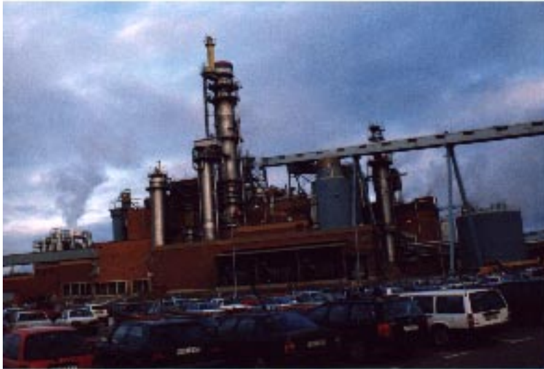
Bild 2.1. Vy över Gruvöns anläggning.
