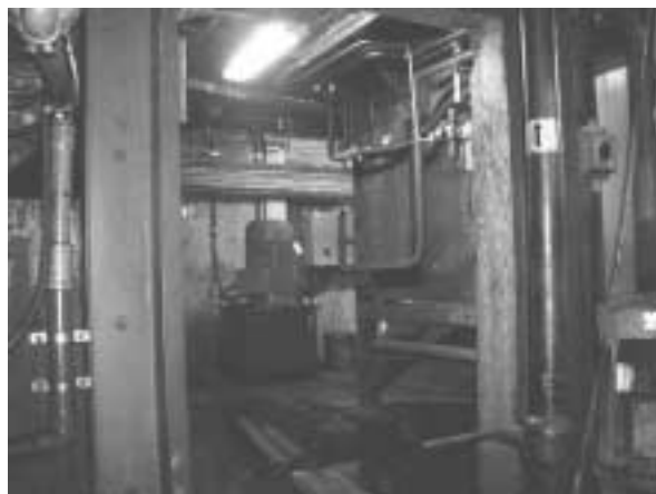
Bild 4.2 Källare under gjutmaskin
