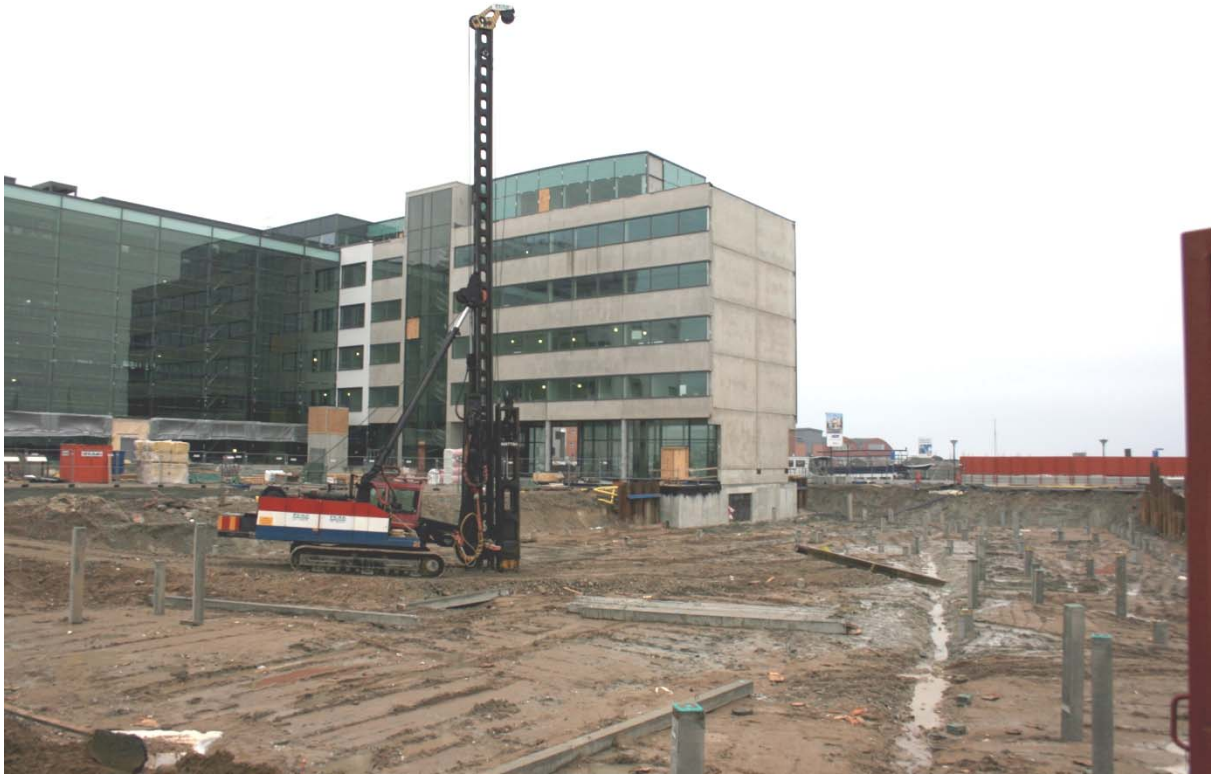
Figur 1 Pålmaskin i arbete på Dockterrassen
