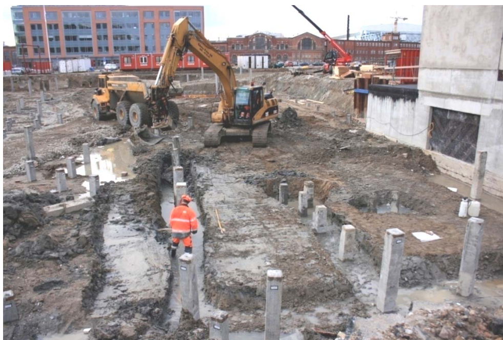
Figur 11 Grundläggningsarbete på Dockterrassen
