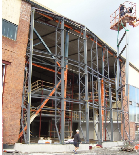
Figur 2.2: Montering av stomprofiler.
