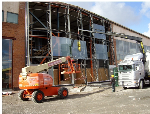
Figur 2.3: Montering av glaspaket.
