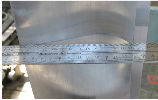
Figur 4.10: Stor livbuckling vid provning av profiltyp A med sidostabilisering.
