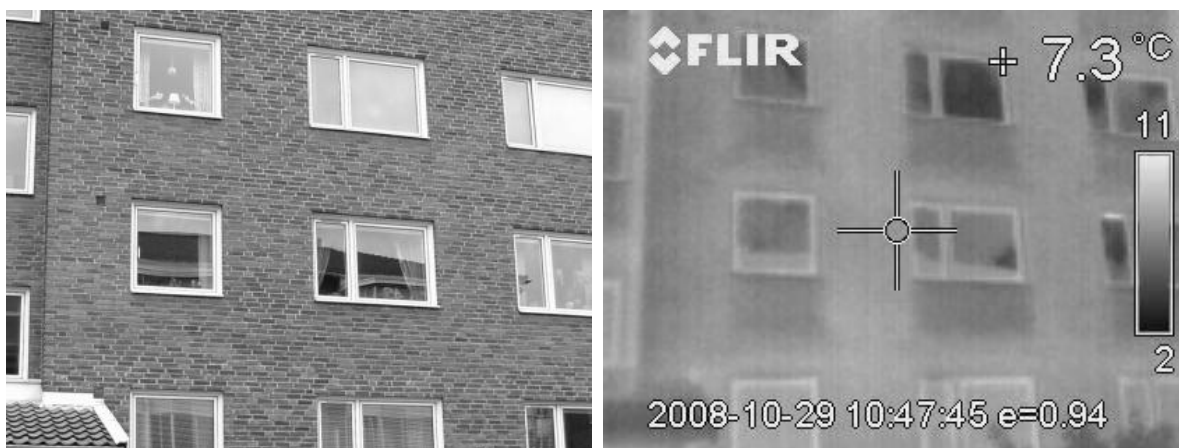
Bild 12 och 13 visar utsidan fotograferat utan och med värmekamera.
