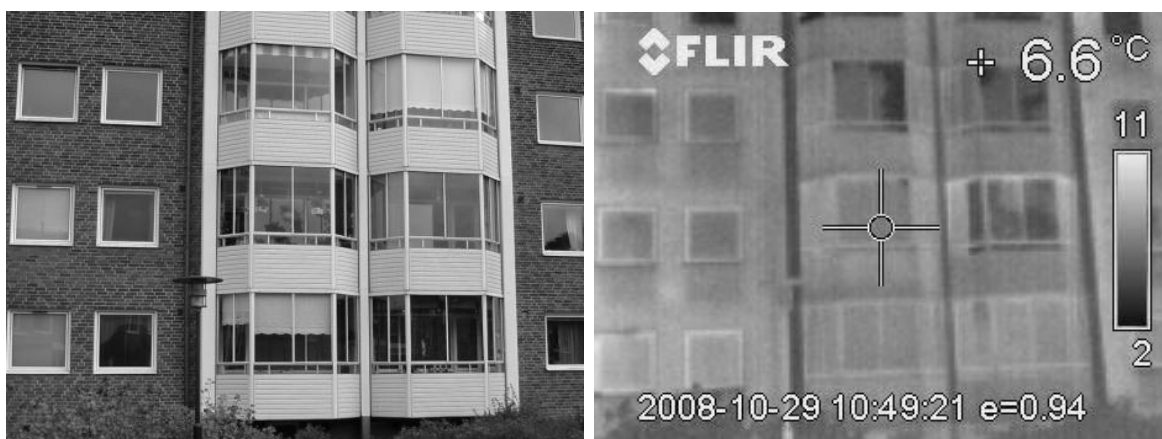
Bild 10 och 11 visar utsidan fotograferat med balkonger utan och med värmekamera.
