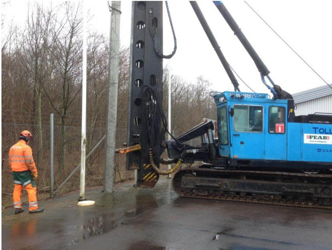
Figur 13. Slagning av pålarna. Foto: Simon Carlsson
