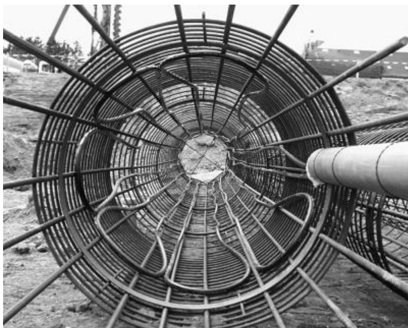
Figur 7. Bilden visar en armeringskorg med fastmonterade kollektorrör som ska användas till en borrarad grävpåle, (Brandl 2006).
