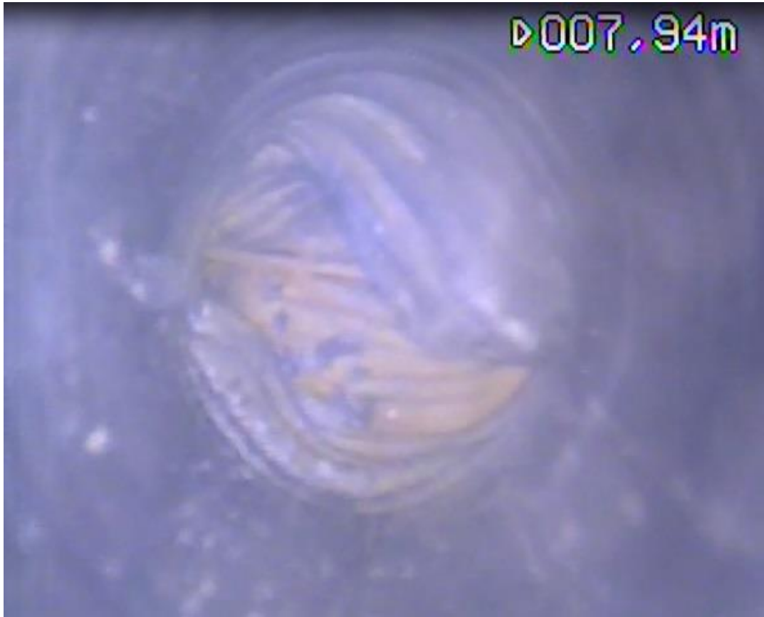
Figur 15. Stillbild från VLT, Video Logging Tool . Botten på påle 1. Notera djupet i över högra hörnet av bilden.
