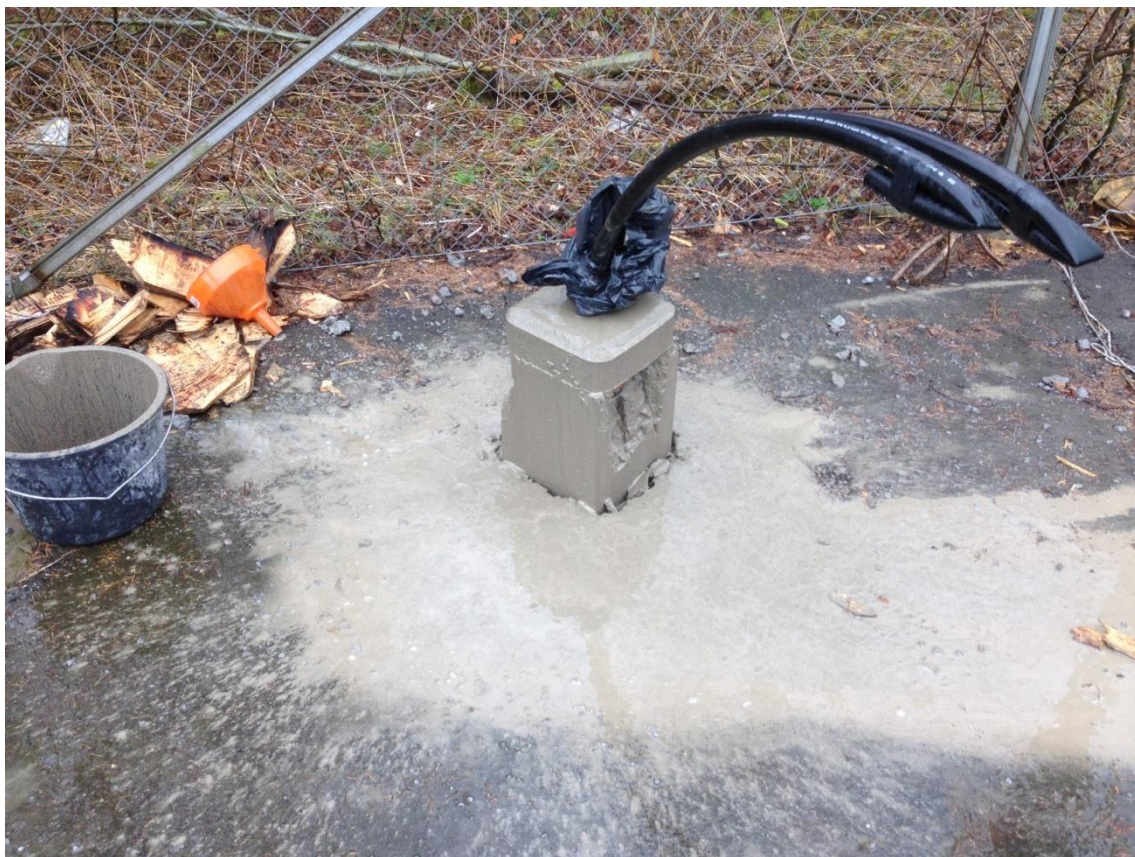
Figur 16. Påle 1 med installerad kollektor precis efter injektering. Foto: Simon Carlsson
