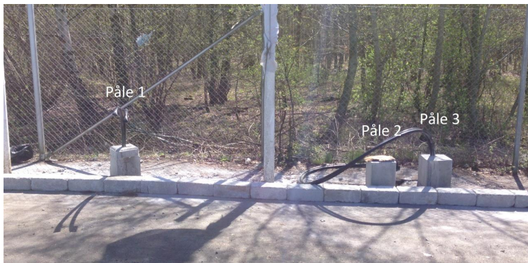
Figur 11. De tre energipålarnas uppställning. Foto: Simon Carlsson
