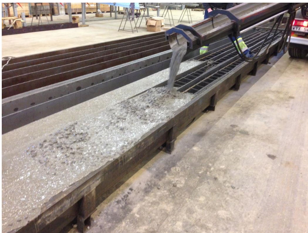
Figur 12. Gjutning av pålarna. Foto: Simon Carlsson
