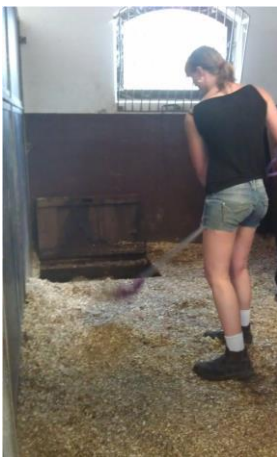
Figur 6. Utgödslingen i stall 2 sker genom luckor i boxgolvet, där gödslet transporteras vidare under stallet med hjälp av
