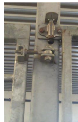
Figur 3. Haspen som lätt för att öppna boxdörren.
